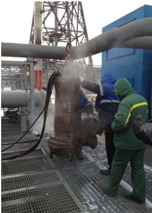
Блок обратного водоснабжения холодной воды. ОАО "Газпромнефть-Омский НПЗ". 4 насоса Flygt CP 3231.605, производительностью 1200 м³/ч каждый
