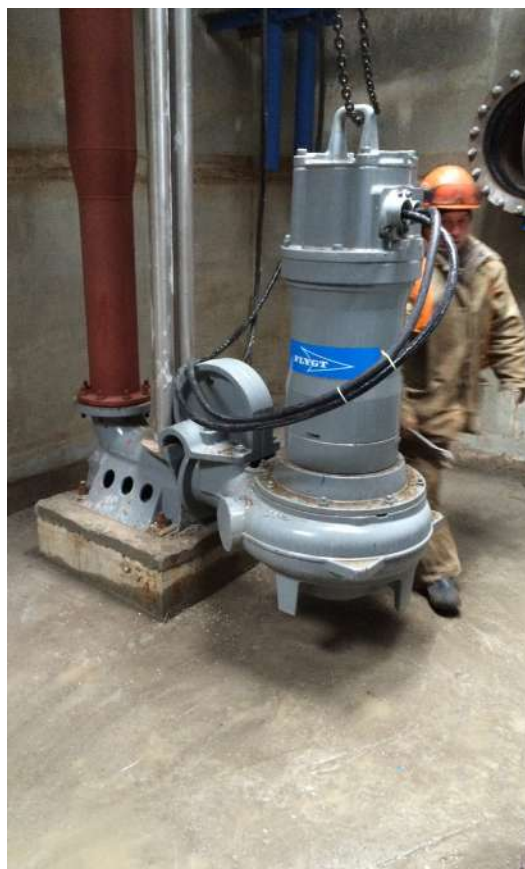
Блок обратного водоснабжения холодной воды. ОАО "Газпромнефть-Омский НПЗ". 4 насоса Flygt CP 3231.605, производительностью 1200 м³/ч каждый
