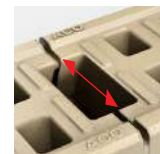
Широкое отверстие на стыке каналов
