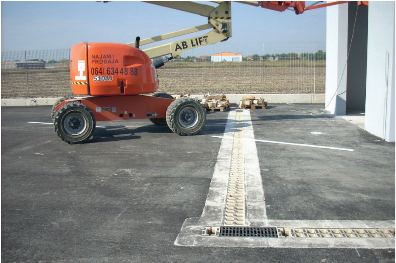
Каналы после укладки верхнего покрытия площадки
