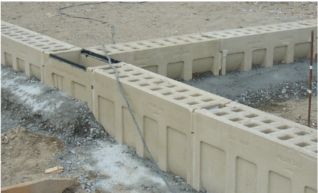
Устройство Т-образного соединения каналов
