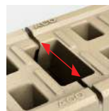
Широкое отверстие на стыке каналов
