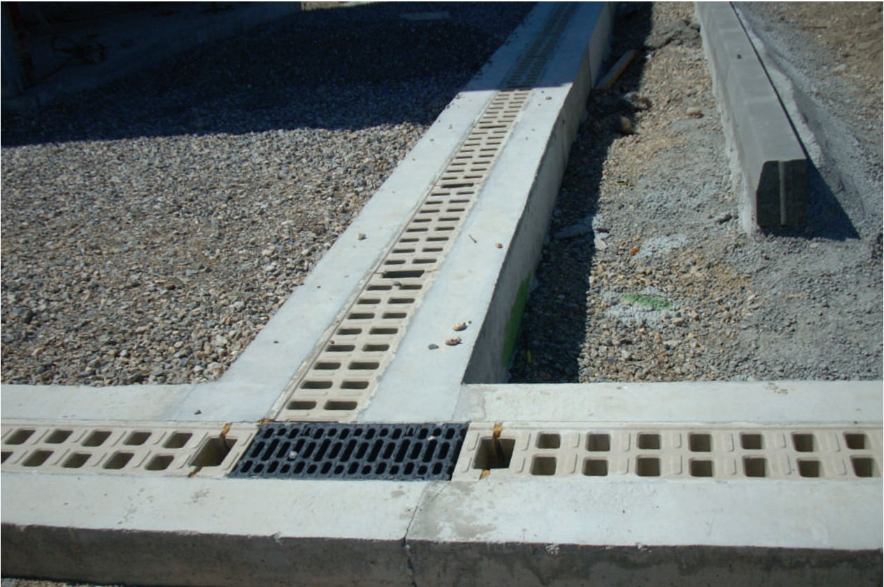
Каналы в бетонной обойме
