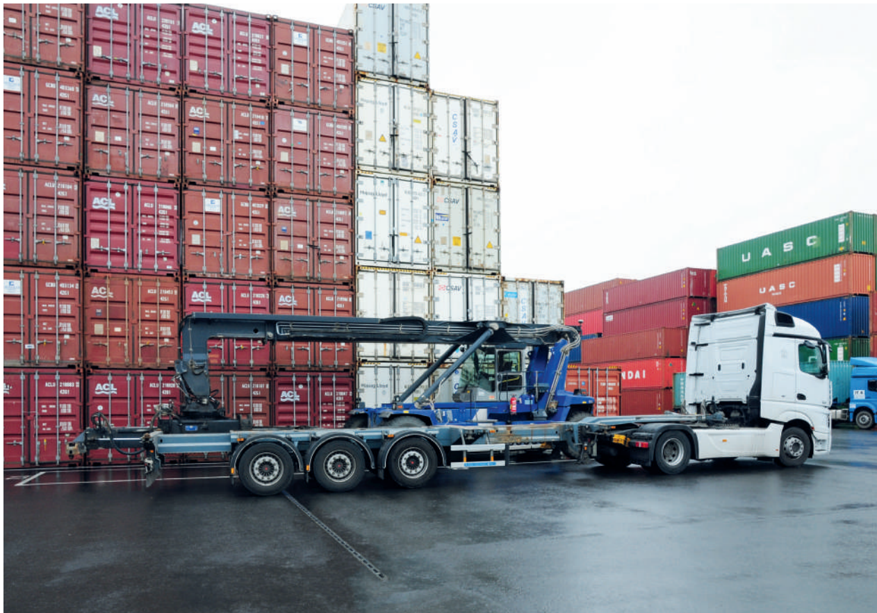
Установка на площадке контейнерного терминала 210 м каналов ACO Qmax 550/700
