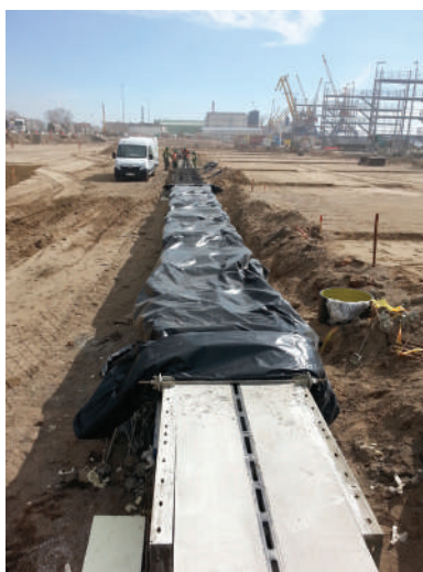
Устройство бетонной обоймы каналов ACO Qmax
