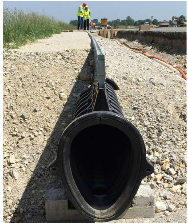
Засыпка ПГС с послойным уплотнением
