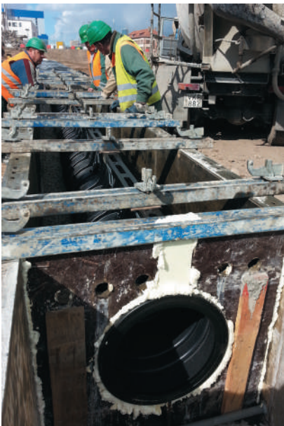
«Вывешивание» каналов перед заливкой бетонной обоймы. Армирование при необходимости
