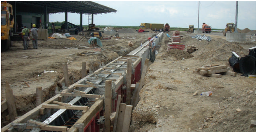
Устройство армированного бетонного основания
