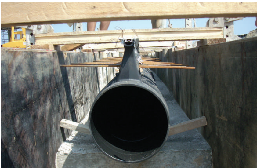
Устройство армирования дорожного полотна
