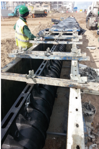
«Вывешивание» каналов перед заливкой бетонной обоймы. Армирование при необходимости
