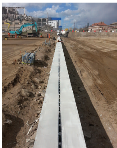
Устройство бетонной обоймы каналов ACO Qmax
