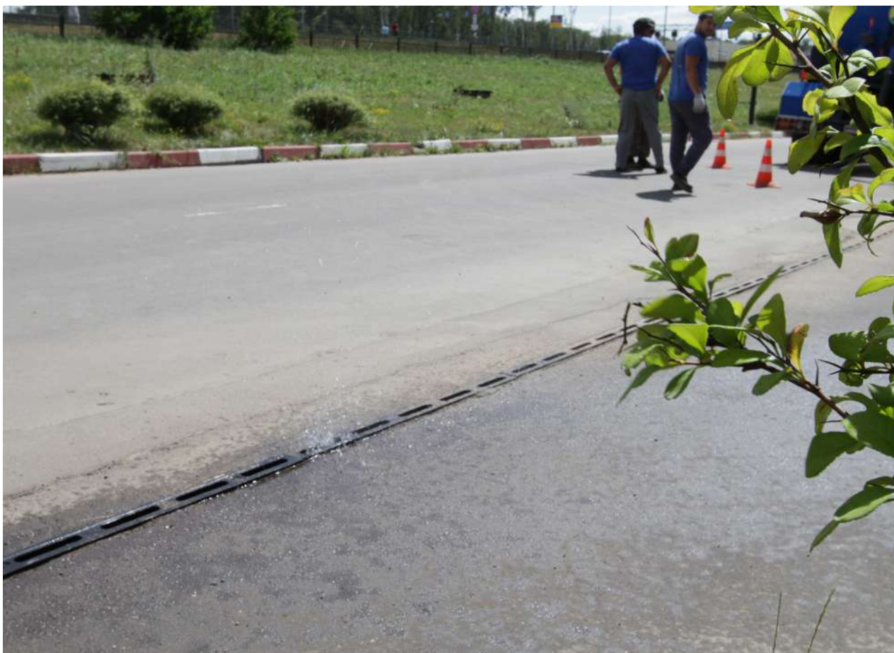
Канал в процессе промывки гидродинамическим способом
