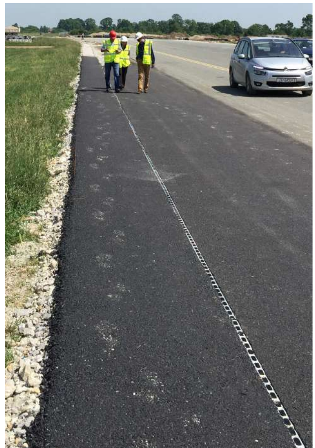
Установленная линия каналов
