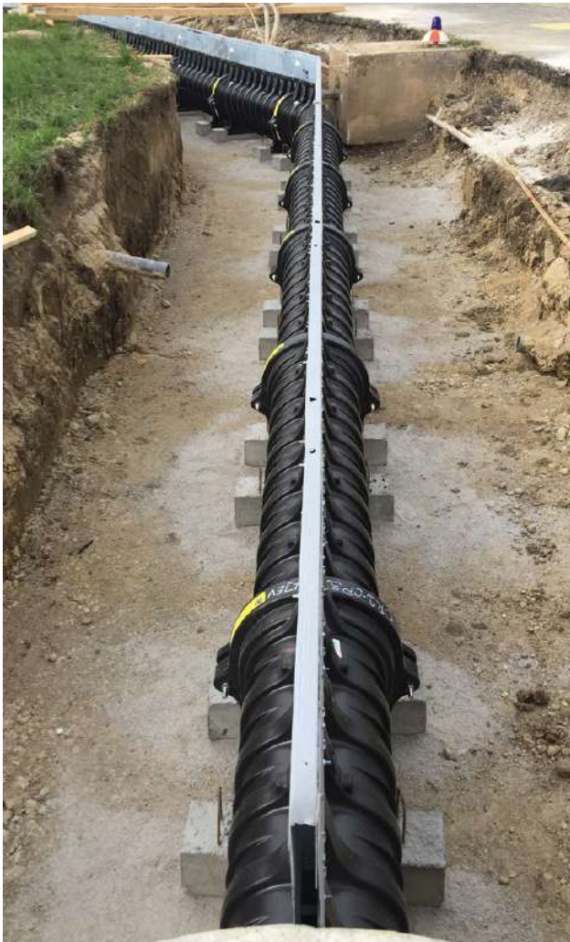
Бетонирование основания под ножки каналов
