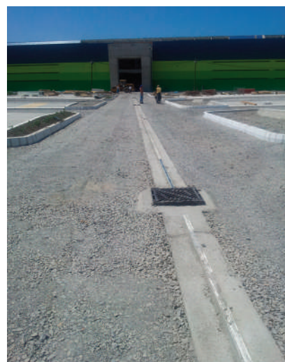
Устройство верхнего покрытия площадки
