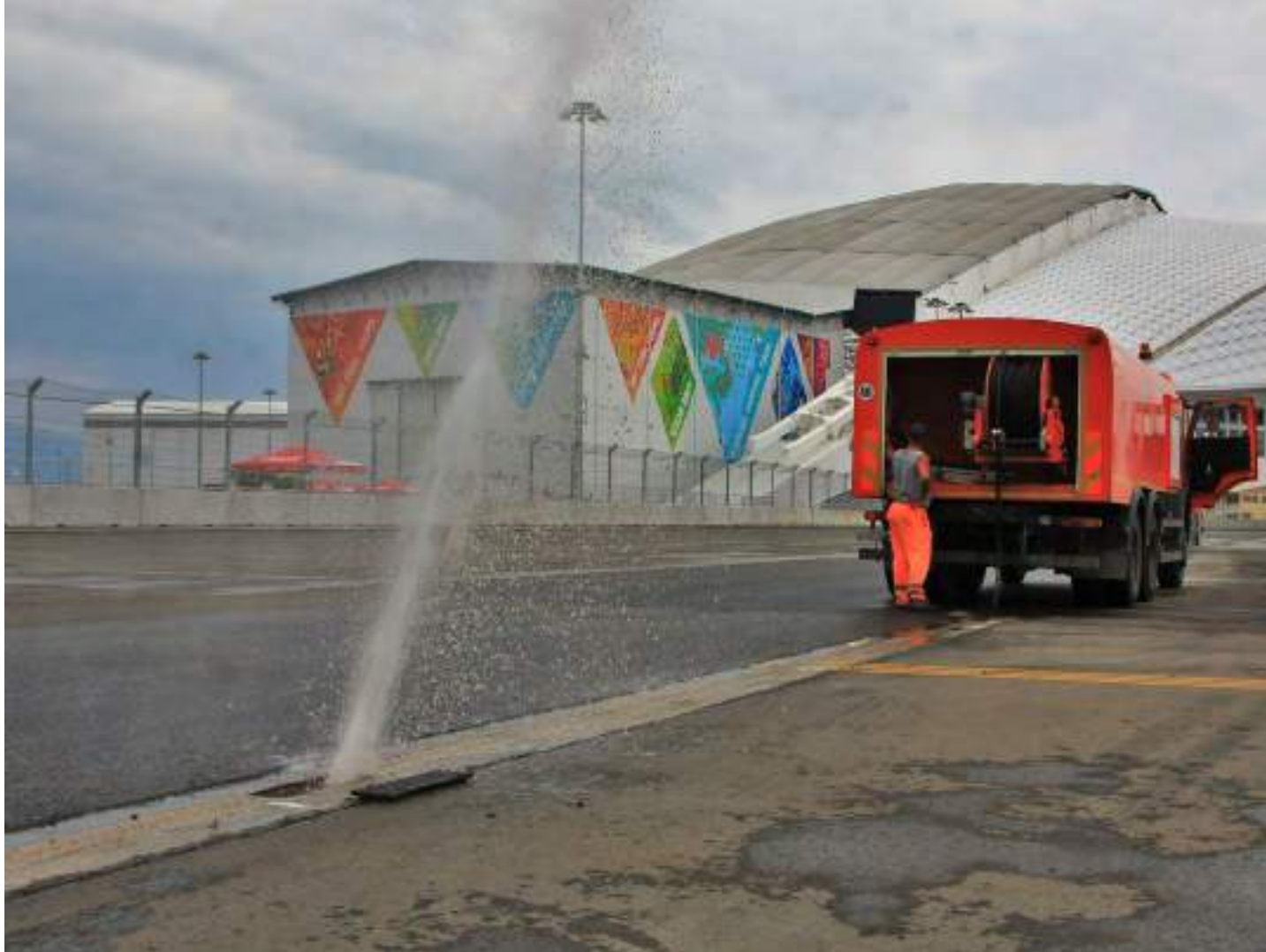
Канал в процессе прочистки гидродинамическим способом
