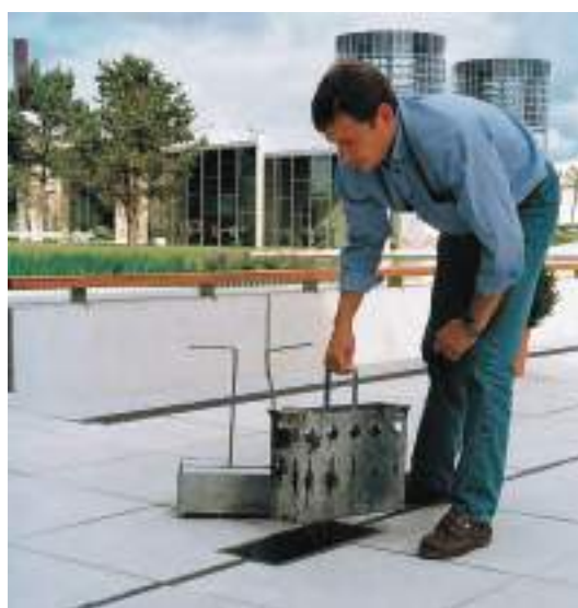
Обслуживание системы ACO Multiline со щелевыми насадками.
