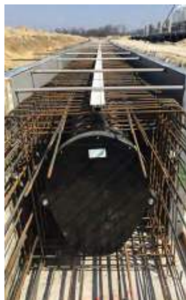
«Вывешивание» каналов перед заливкой бетонной обоймы. Армирование при необходимости
