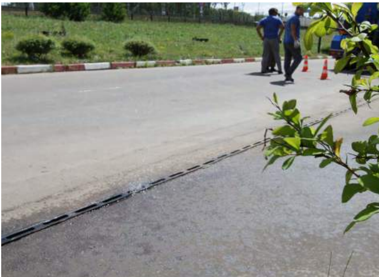
Канал в процессе промывки гидродинамическим способом
