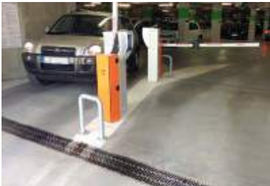
Примеры установленных линий каналов
