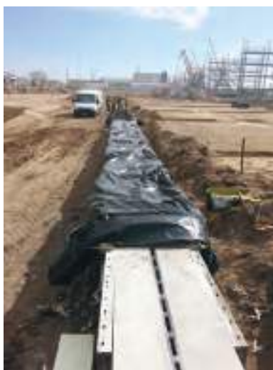
Устройство бетонной обоймы каналов ACO Qmax
