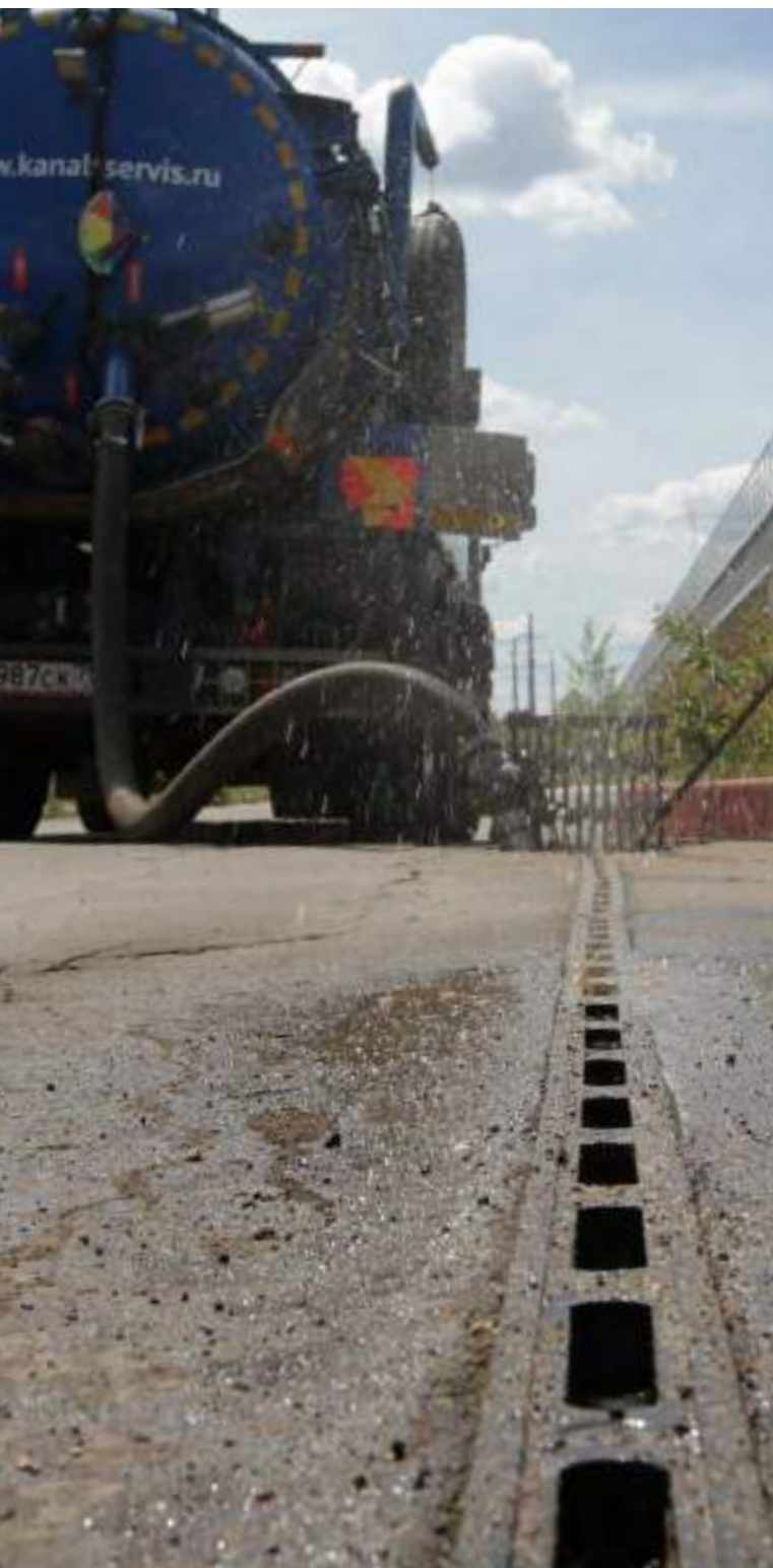
Гидродинамическая промывка линии канала на расстоянии до 100 м
