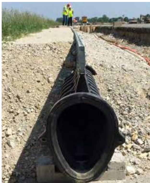
Засыпка ПГС с послойным уплотнением
