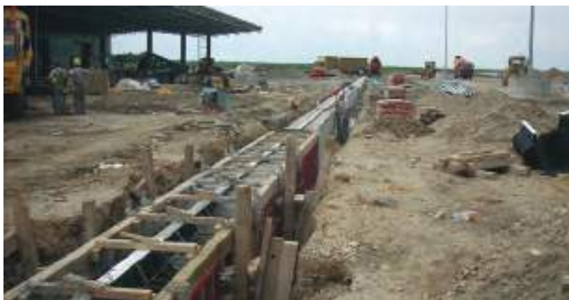
Устройство армированного бетонного основания
