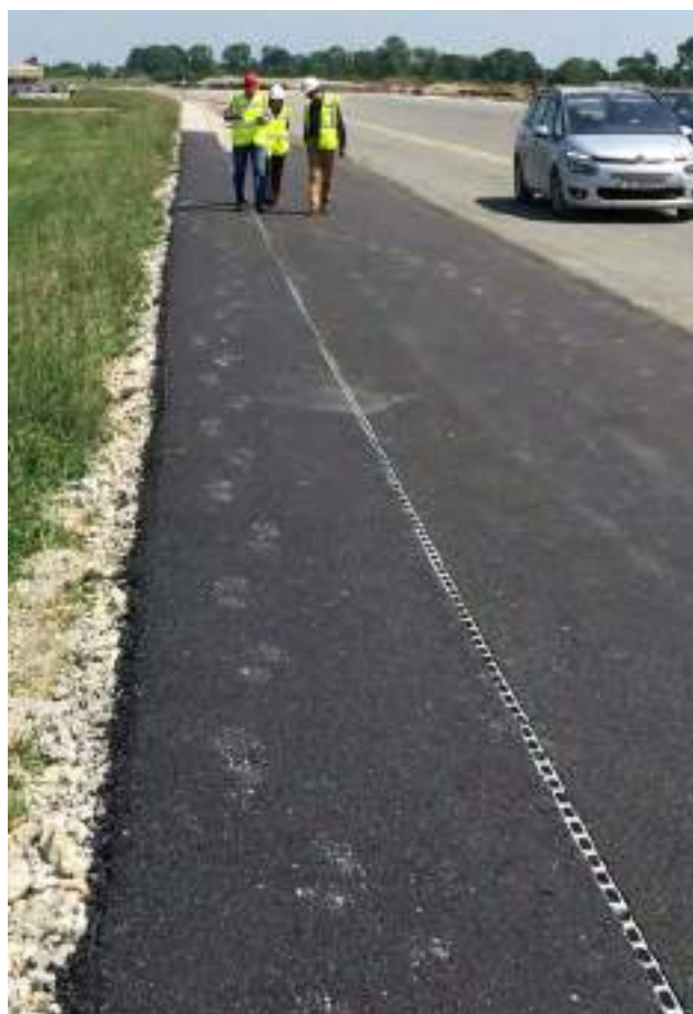
Установленная линия каналов
