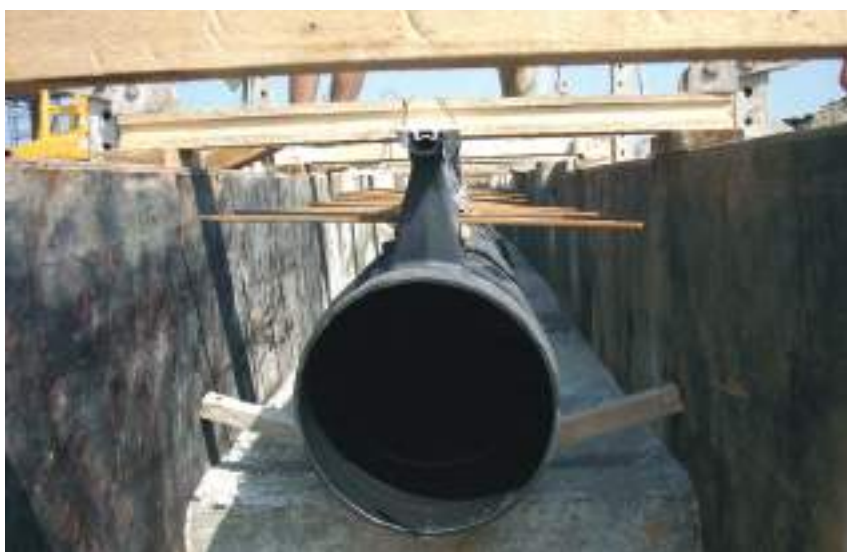
Устройство армирования дорожного полотна
