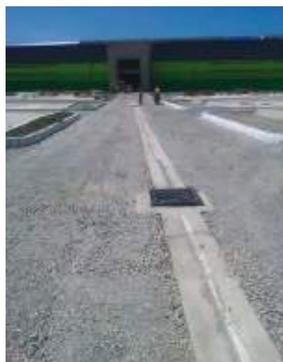
Устройство верхнего покрытия площадки
