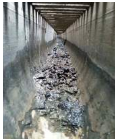
Канал до очистки
