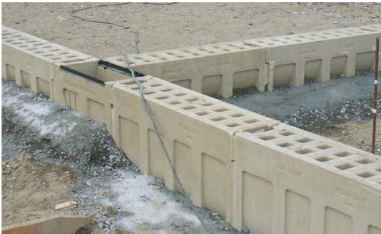
Устройство Т-образного соединения каналов
