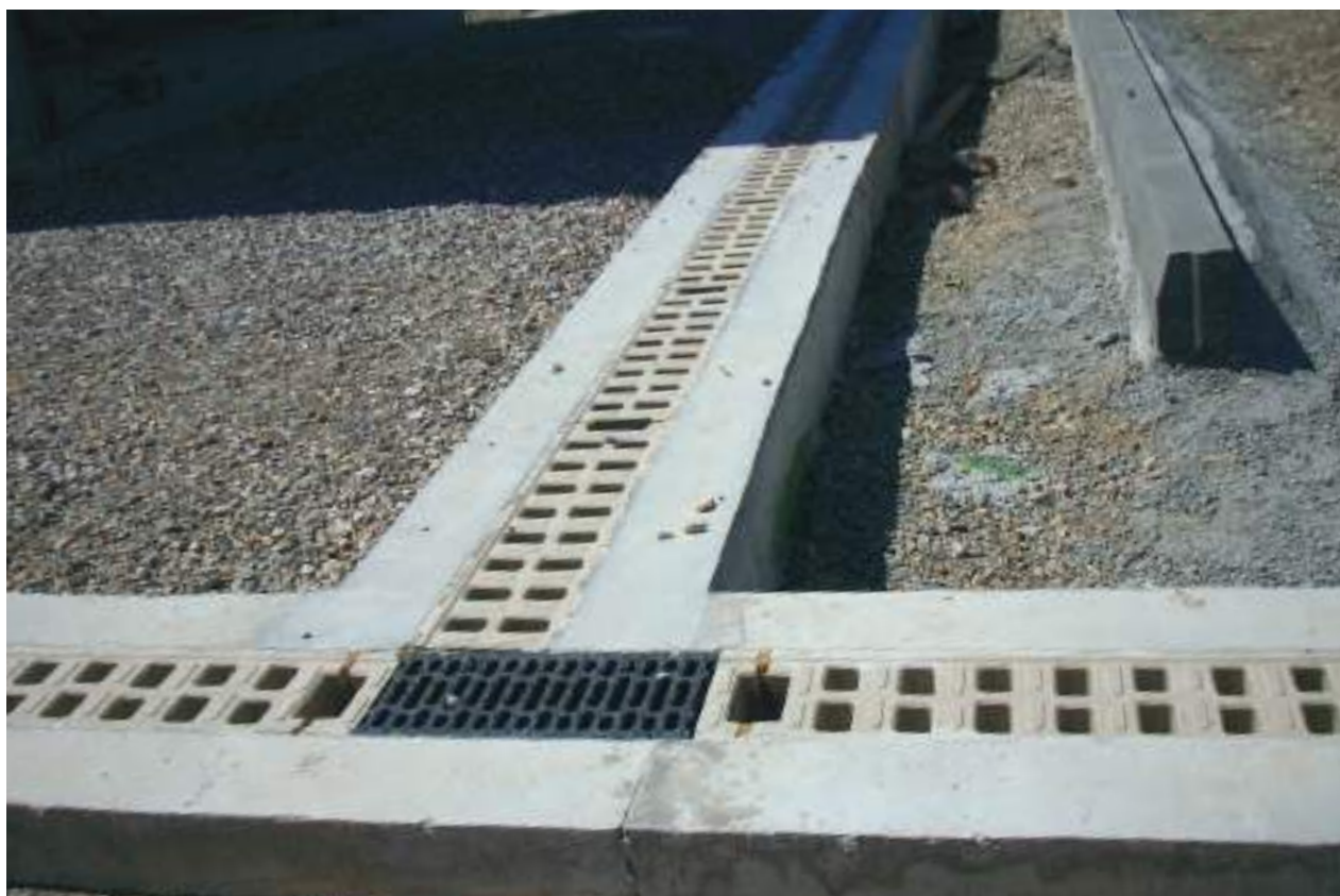
Каналы в бетонной обойме
