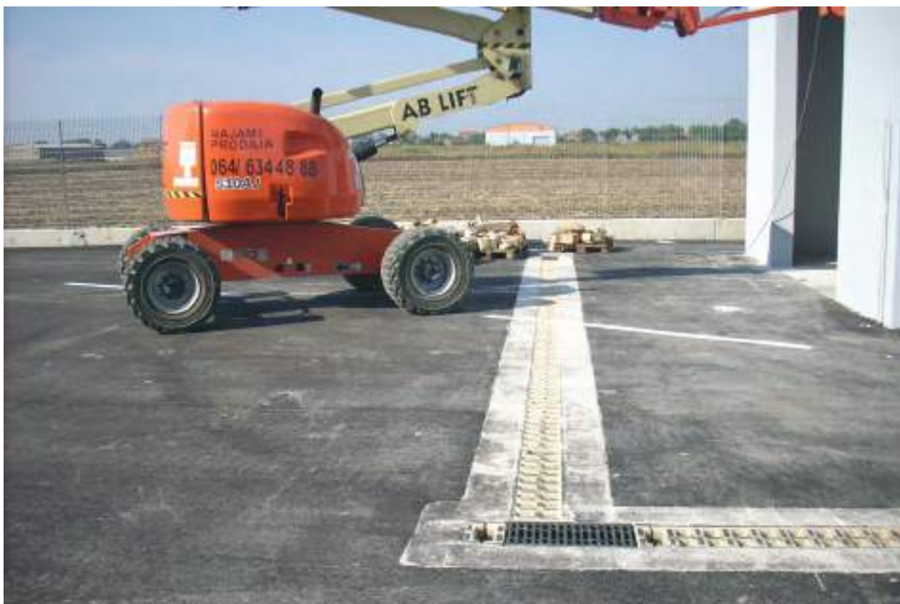
Каналы после укладки верхнего покрытия площадки
