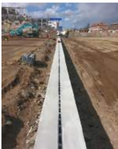
Устройство бетонной обоймы каналов ACO Qmax
