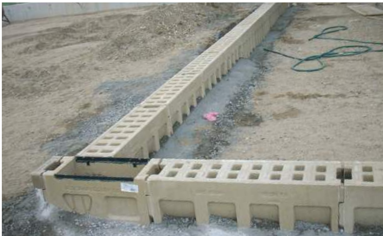
Устройство L-образного соединения каналов
