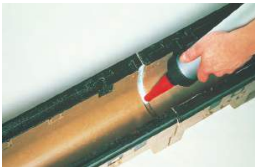
Нанесение герметизирующей массы
