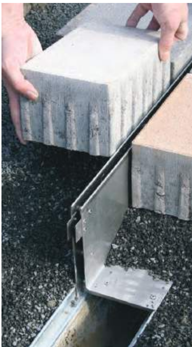
Монтаж системы ACO Drain® Multiline с применением щелевых насадок
