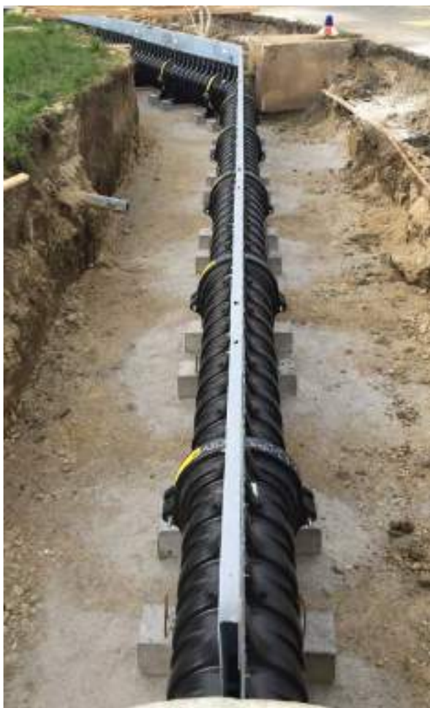
Бетонирование основания под ножки каналов
