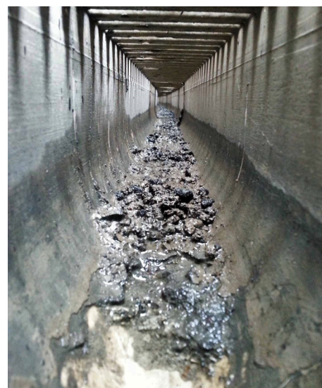
Канал до очистки
