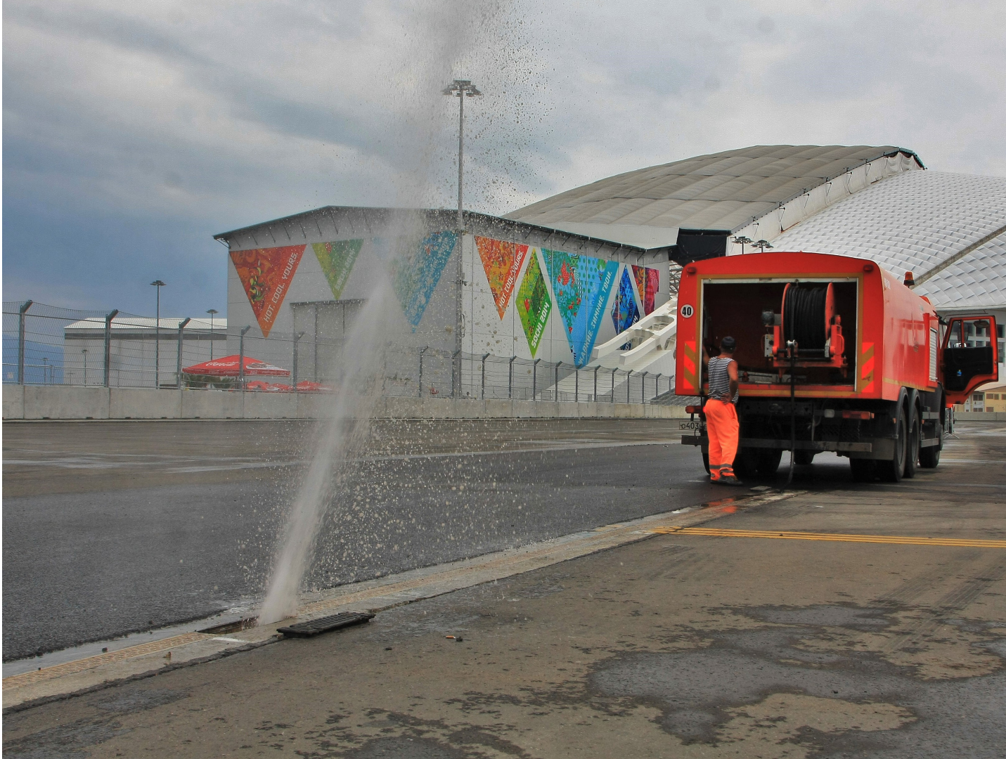
Канал в процессе прочистки гидродинамическим способом
