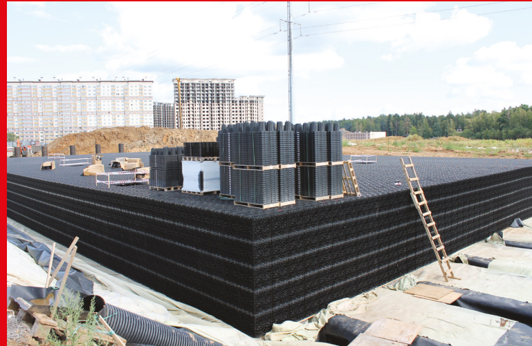
■ Аккумулирующая емкость объемом 5000 м 3 в составе очистных сооружений дождевой канализации транспортной развязки МКАД и магистрали М1 "Беларусь", Московская обл.
