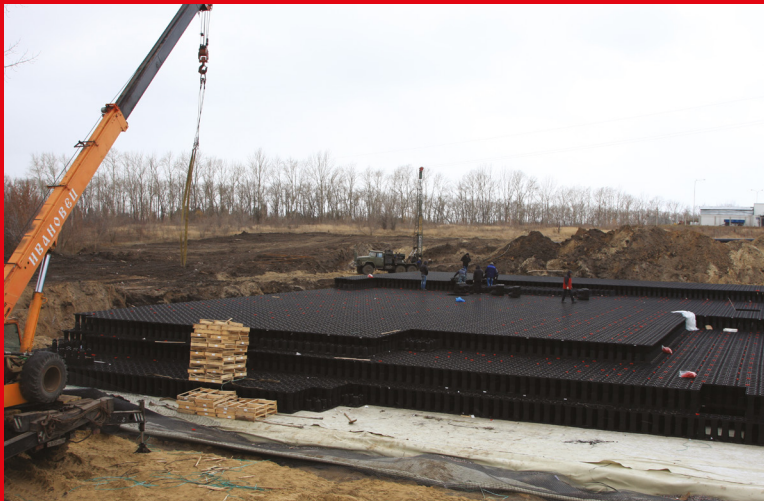
■ Аккумулирующая емкость объемом 6050 м 3 в составе очистных сооружений канализации Индустриального парка "Масловский", г. Воронеж
