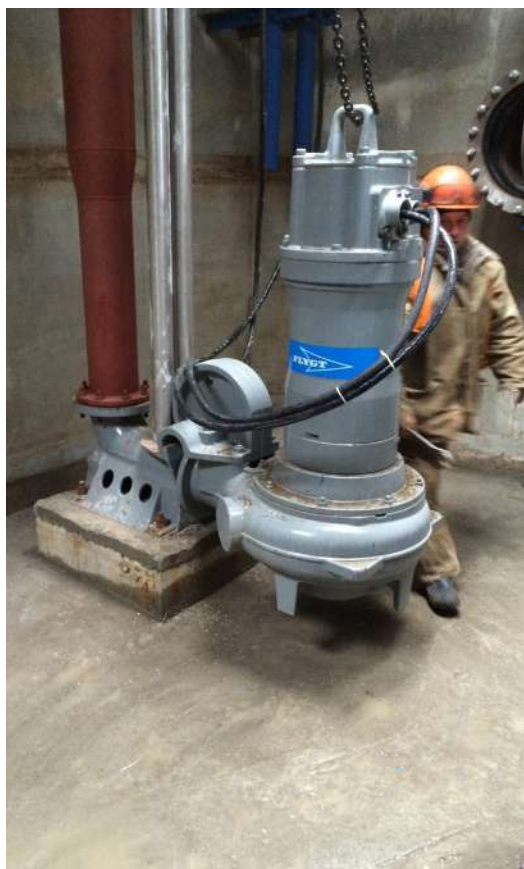
Блок обратного водоснабжения холодной воды. ОАО "Газпромнефть-Омский НПЗ". 4 насоса Flygt CP 3231.605, производительностью 1200 м 3 /ч каждый
