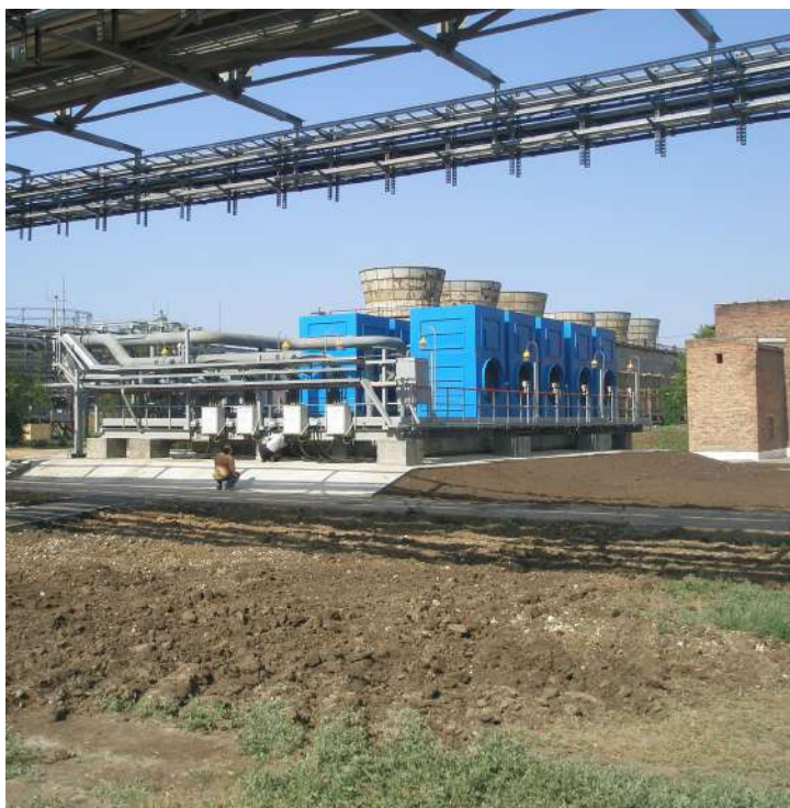
Поставка насосов FLYGT для ОАО "КуйбышевАзот". Проект: "Производство Полиамида-6, III-очередь строительства. Водооборотный цикл". Насосное оборудование: 4 насоса FLYGT NP3231.735. Мощность привода 170 кВт.
