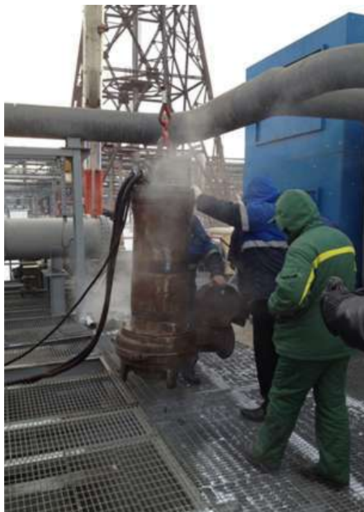
Блок обратного водоснабжения холодной воды. ОАО "Газпромнефть-Омский НПЗ". 4 насоса Flygt CP 3231.605, производительностью 1200 м 3 /ч каждый
