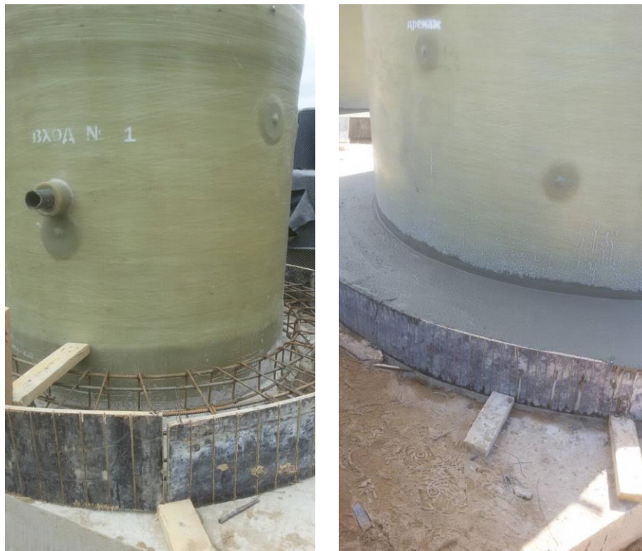
Рисунок 3 – Пример устройства пригруза корпуса
