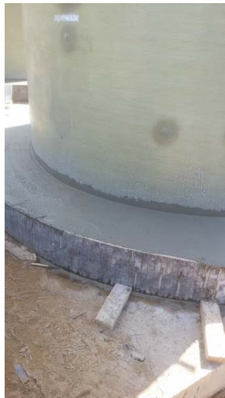
Рисунок 6 – Пример устройства пригруза корпуса
