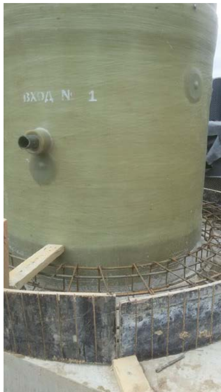
Рисунок 6 – Пример устройства пригруза корпуса
