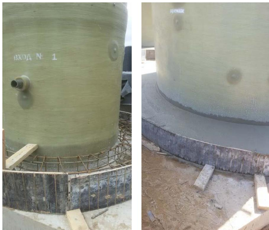
**Рис. 9 – Пример устройства пригруза корпуса**
