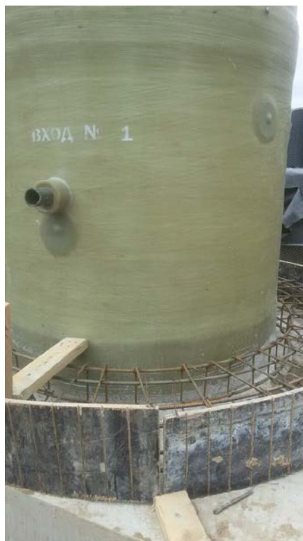
Рис. 11 – Пример устройства пригруза корпуса
