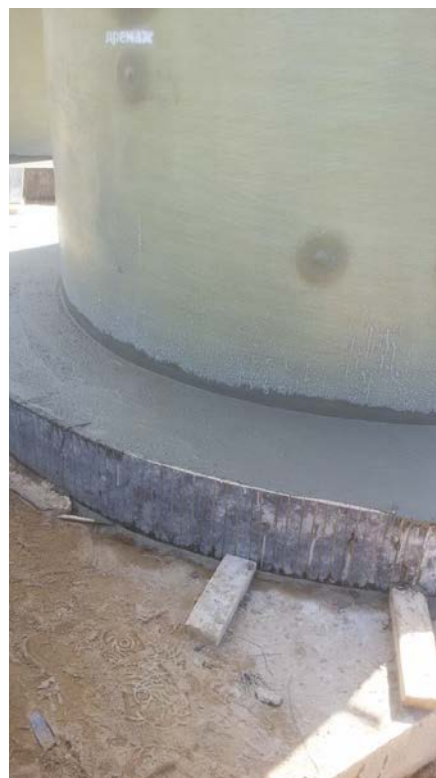
Рис. 11 – Пример устройства пригруза корпуса
