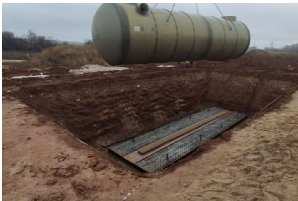
Рис. 9 – Метод строповки стеклопластиковых корпусов изделий
