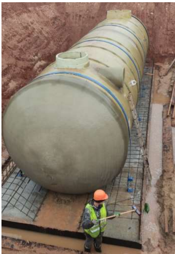
Рис. 11 – Крепление горизонтального изделия к фундаментной ж/б плите
