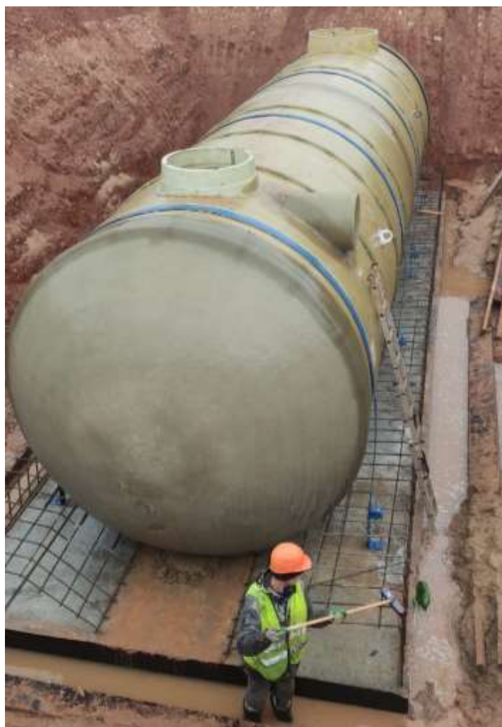
Рис. 8 – Крепление горизонтального изделия к ж/б плите
