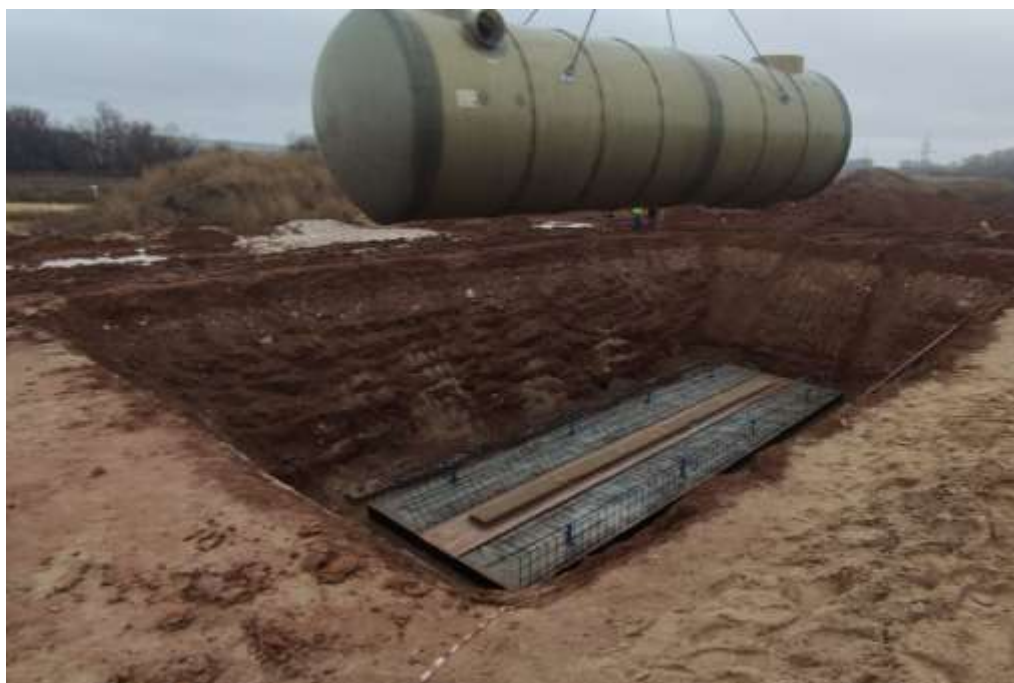
Рис. 6 – Метод строповки стеклопластиковых корпусов изделий
