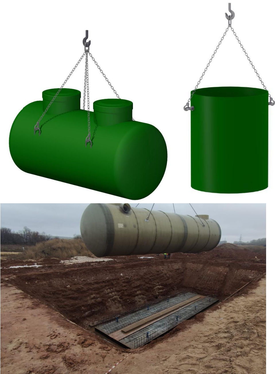
Рисунок 23 – Пример строповки элементов установки
