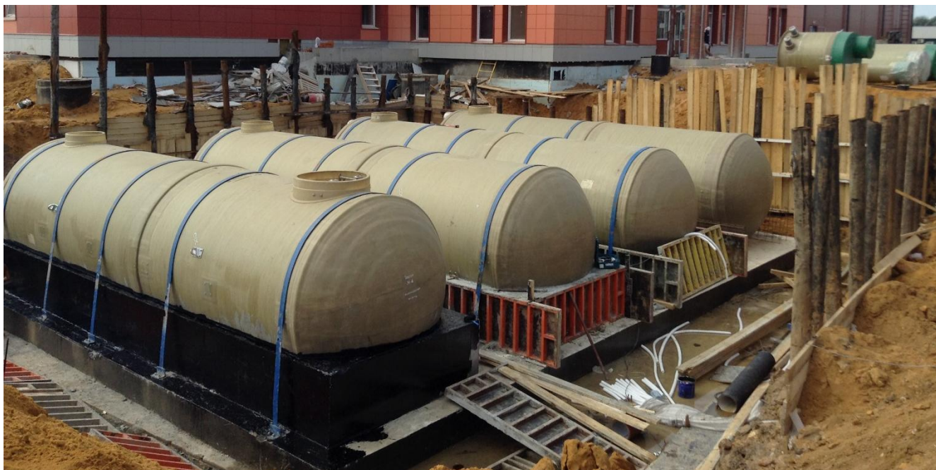
Рисунок 7 – Пример крепления горизонтальных корпусов монтажными лентами
