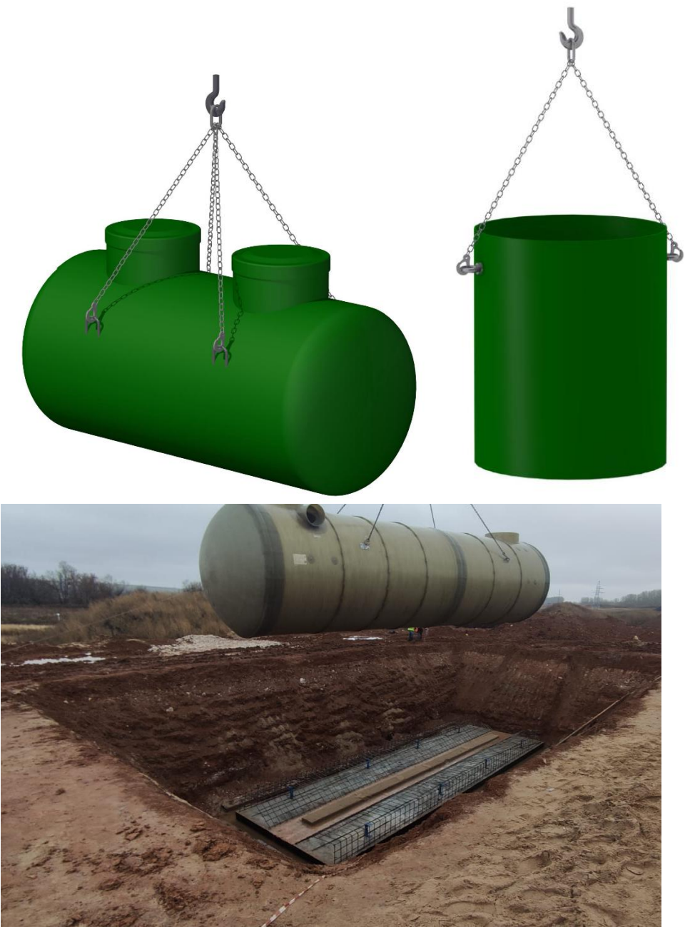
Рисунок 23 – Пример строповки элементов установки
