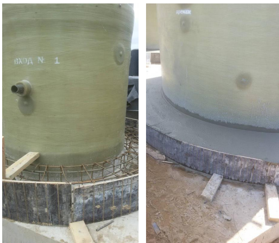
Рисунок 6 – Пример устройства пригруза корпуса
