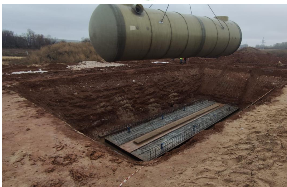
Рисунок 23 – Пример строповки элементов установки
