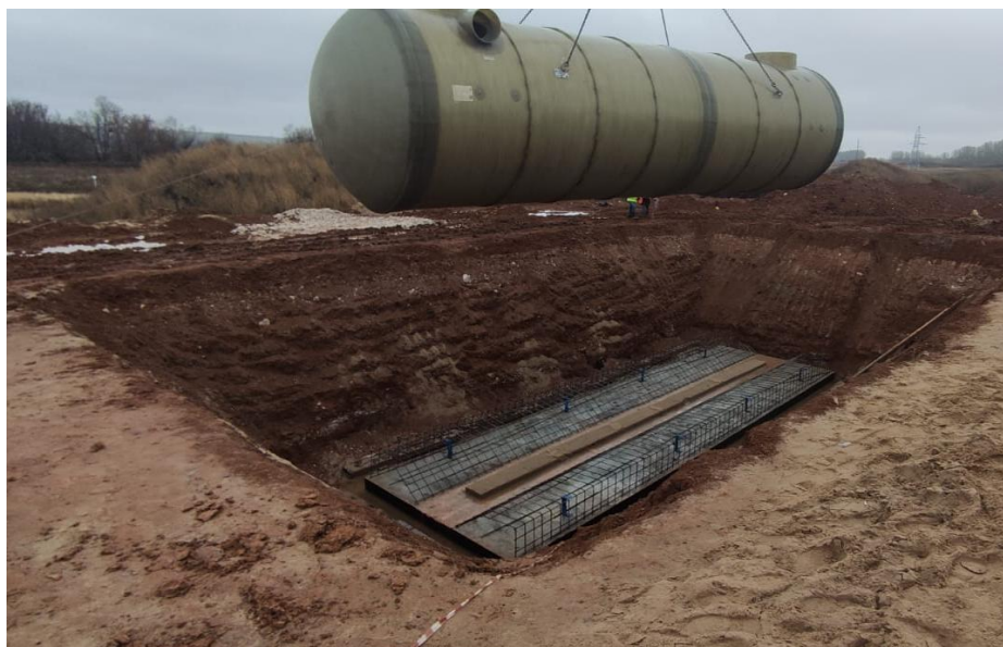
Рисунок 22 – Пример строповки элементов установки
