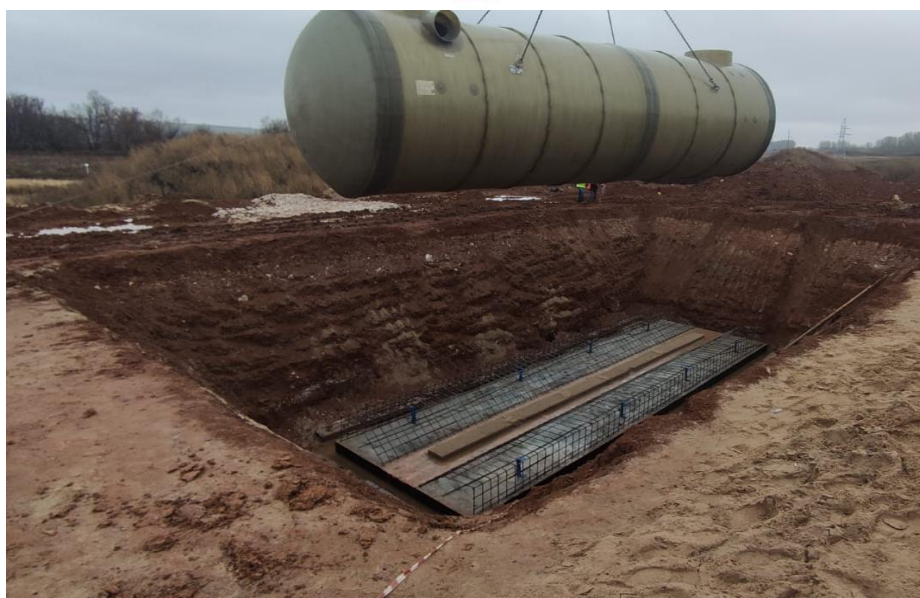
Рисунок 23 – Пример строповки элементов установки
