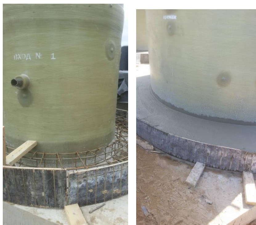
Рисунок 7 – Пример устройства пригруза корпуса
