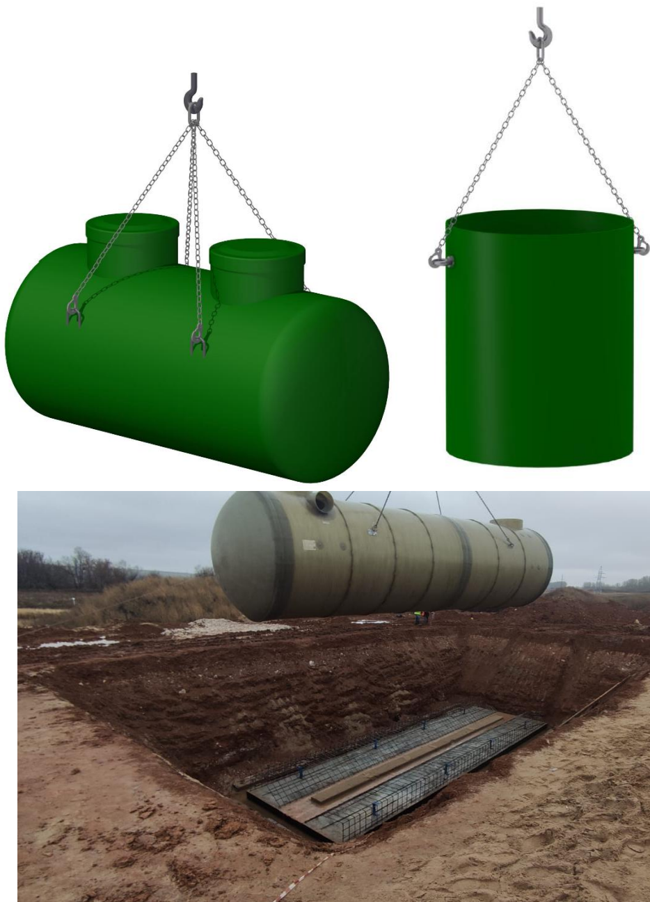
Рисунок 12 – Пример строповки элементов установки
