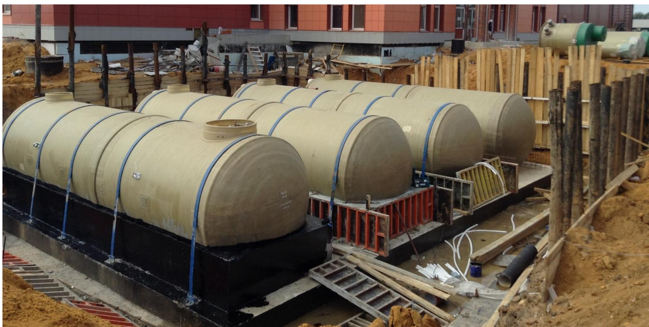
Рисунок 7 – Пример крепления горизонтальных корпусов монтажными лентами
