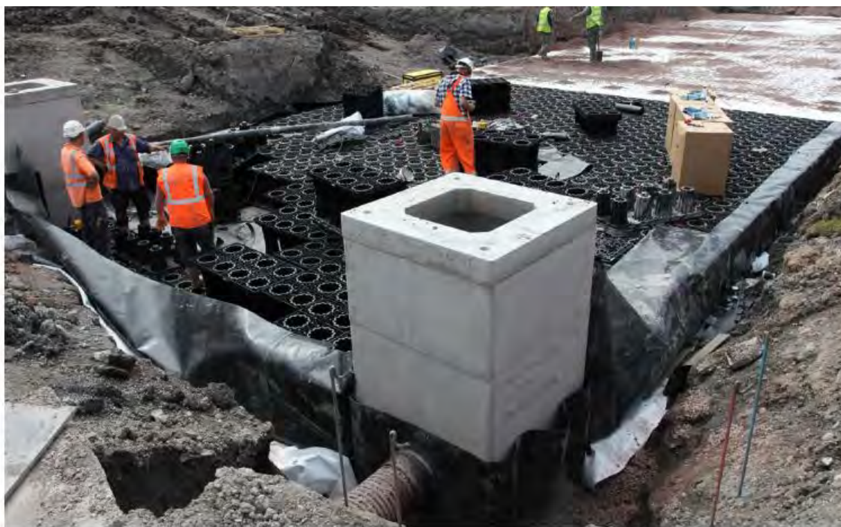
Рис. 42. Монтаж аккумулирующего резервуара ACO StormBrixx с использованием бетонной камеры для подключения трубопровода
