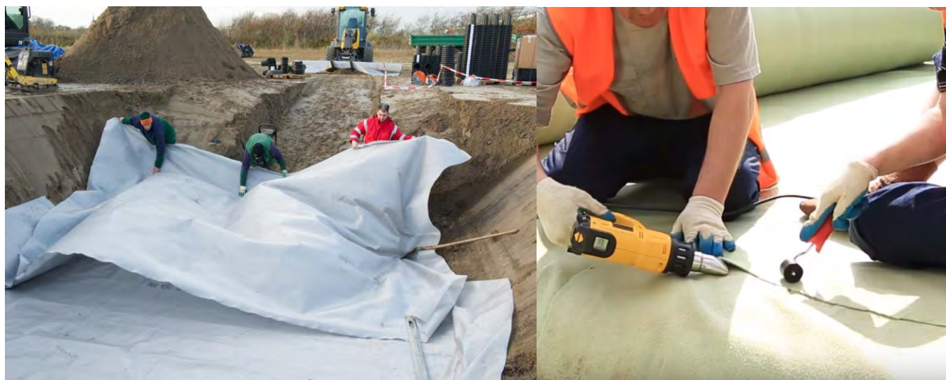
Рис. 20. Укладка и сварка геотекстиля строительным феном
