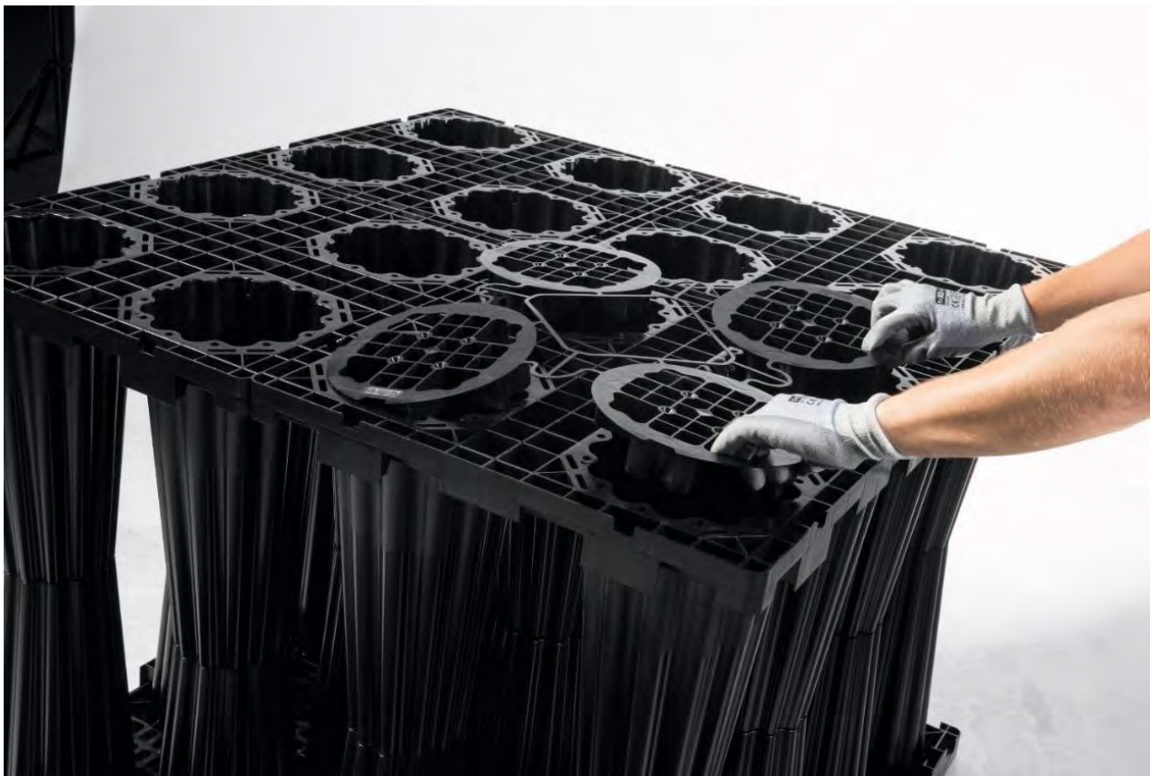
Рис. 29. Установка верхних крышек резервуара.
