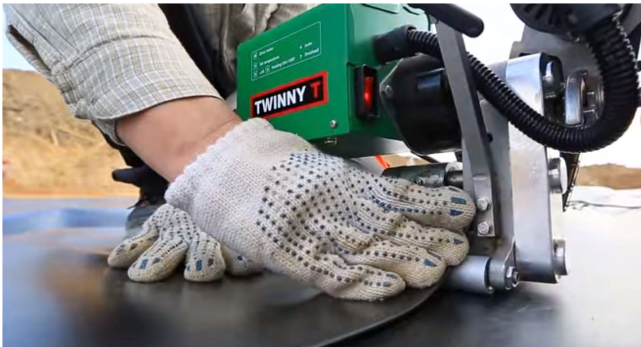
Рис. 21. Сварка геомембраны
