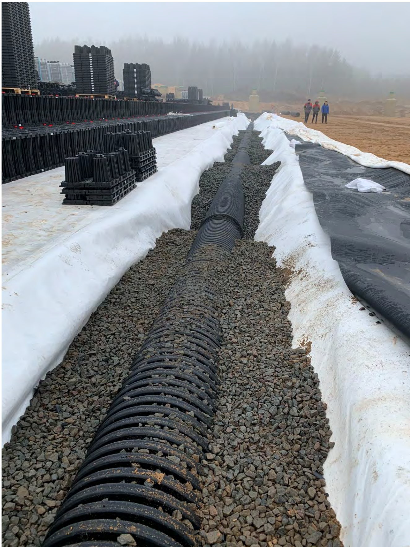
Рис. 19. Прокладка перфорированной трубы и последующее выполнение щебеночной ПОДСЫПКИ
