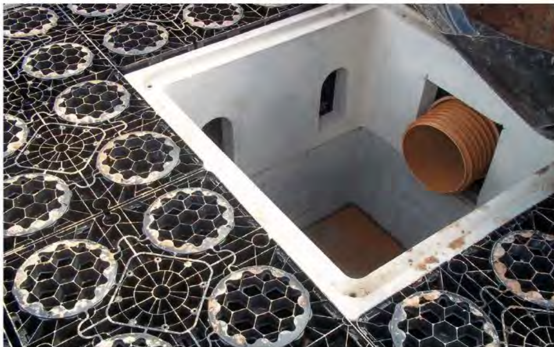
Рис. 43. Бетонная камера для подключения трубопровода, вид изнутри.
