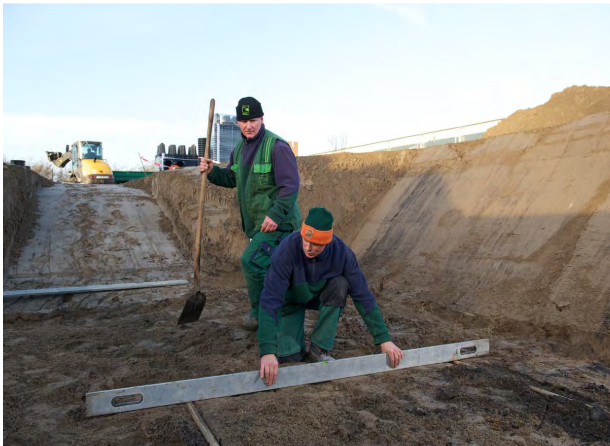
Рис. 16. Выравнивание основания котлована
