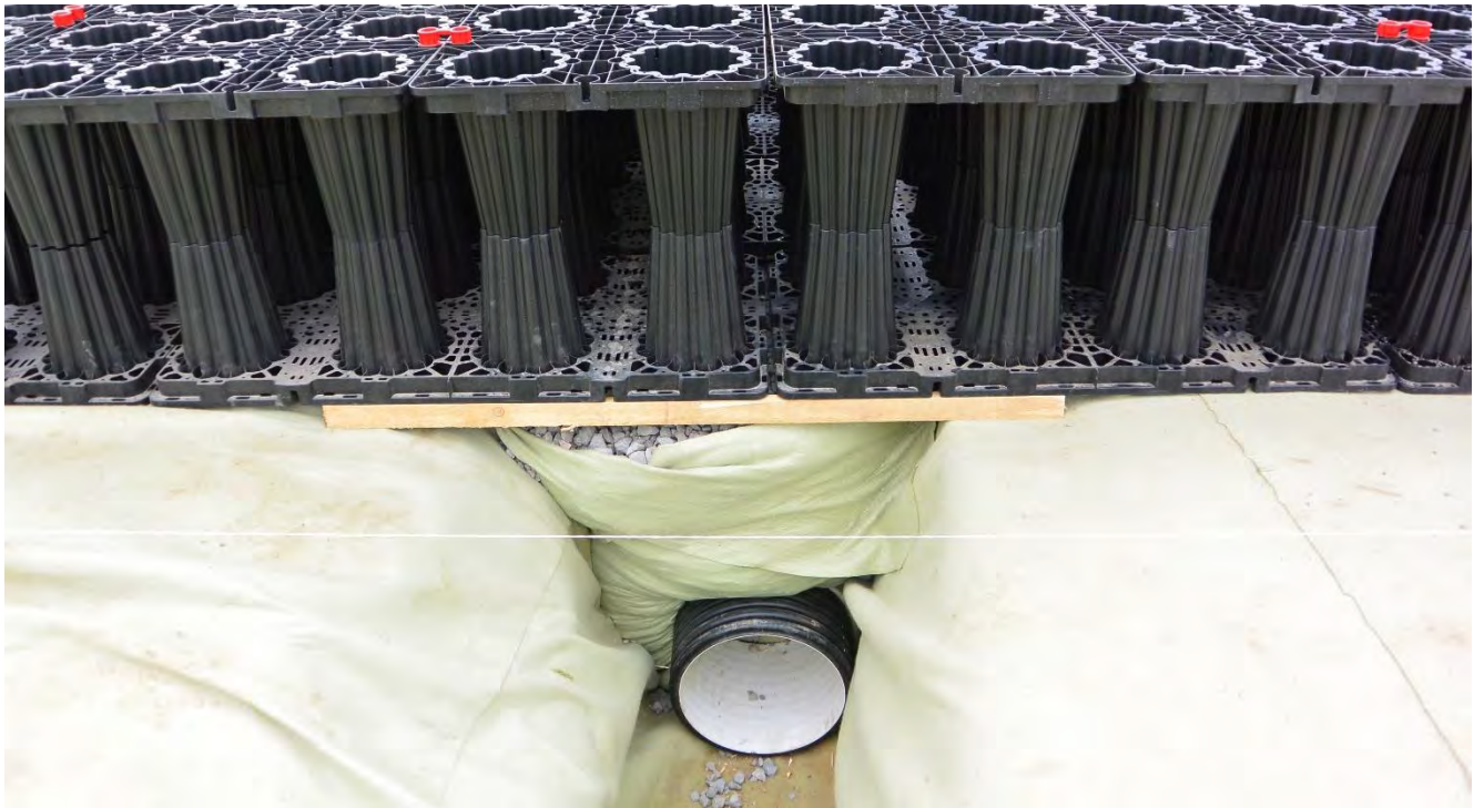
Рис. 18. Процесс монтажа модульной системы ACO StormBrixx
