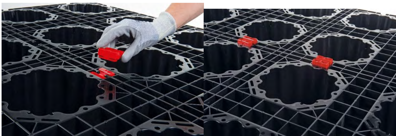
Рис. 27. Установка двойных коннекторов
