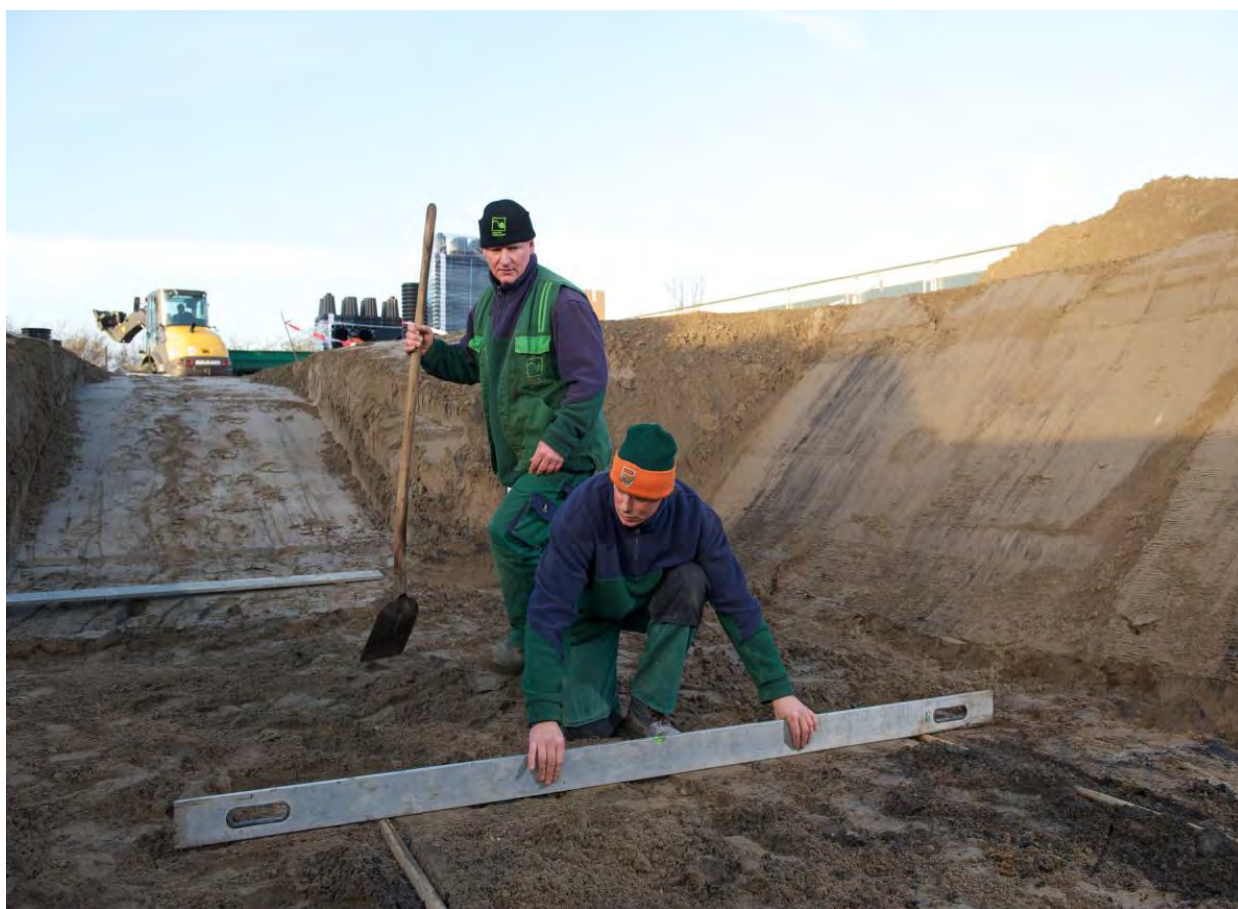
Рис. 9. Выравнивание основания котлована
