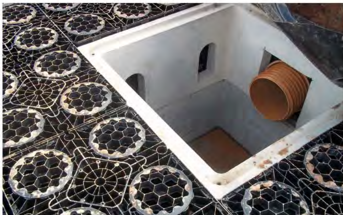
Рис.29. Бетонная камера для подключения трубопровода, вид изнутри.
