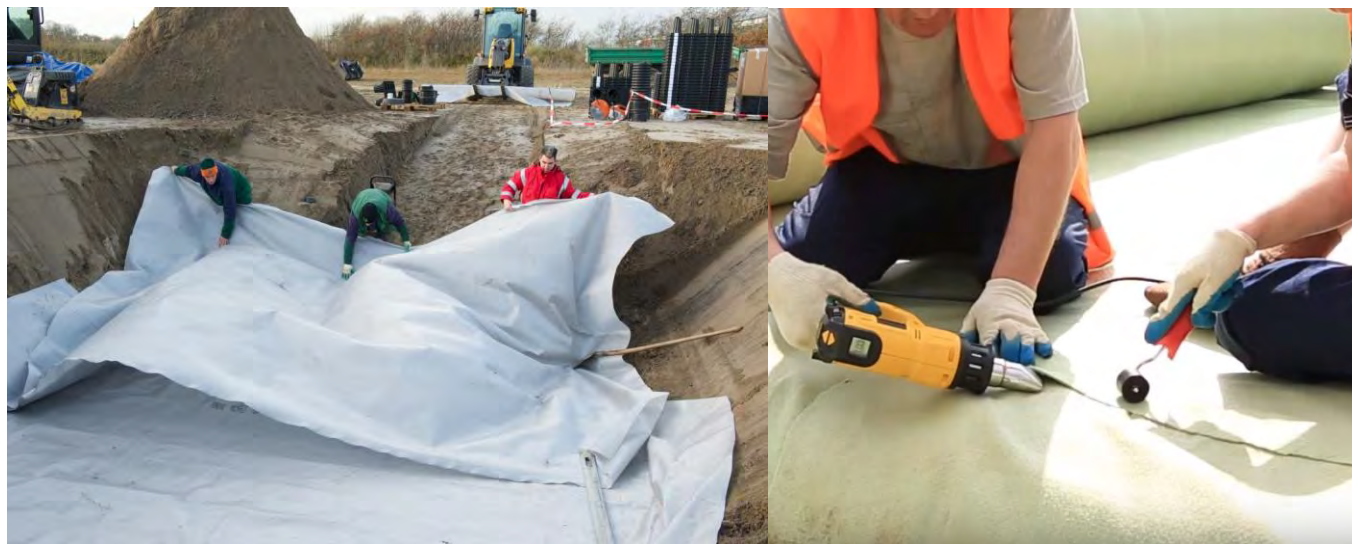
Рис. 10. Укладка и сварка геотекстиля строительным феном
