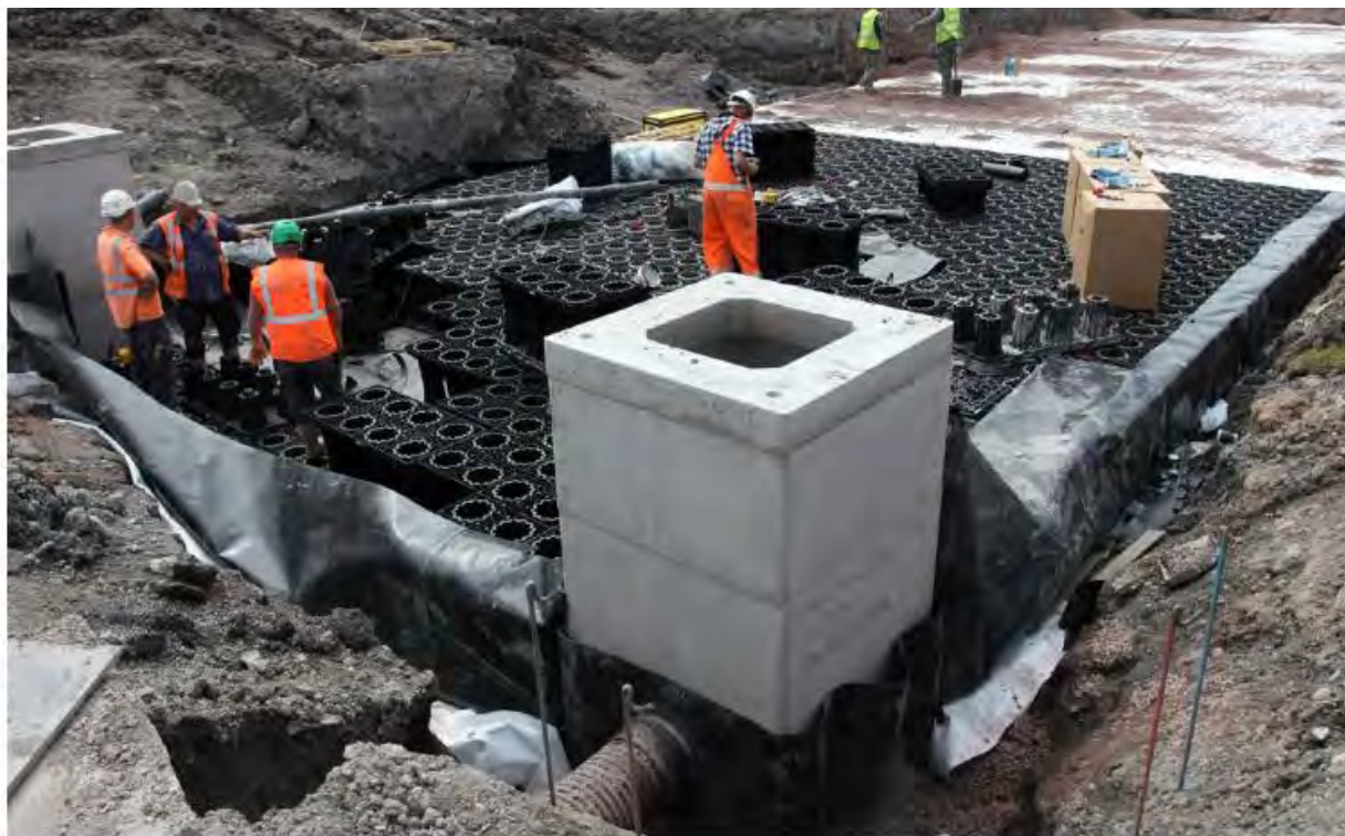
Рис. 28. Монтаж резервуара ACO StormVrixx с использованием бетонной камеры для подключения трубопровода
