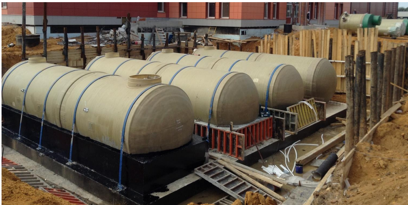
Рисунок 5 – Пример крепления горизонтальных корпусов монтажными лентами
