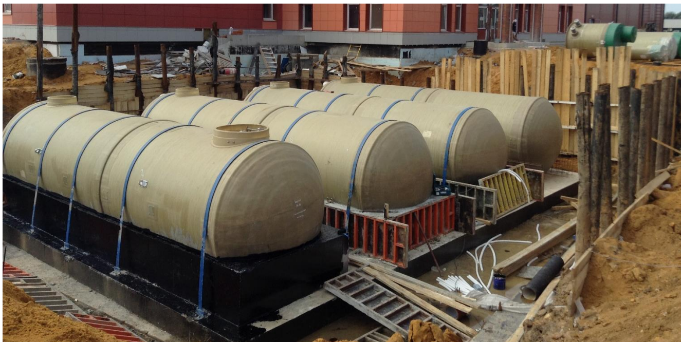
Рисунок 7 – Пример крепления горизонтальных корпусов монтажными лентами
