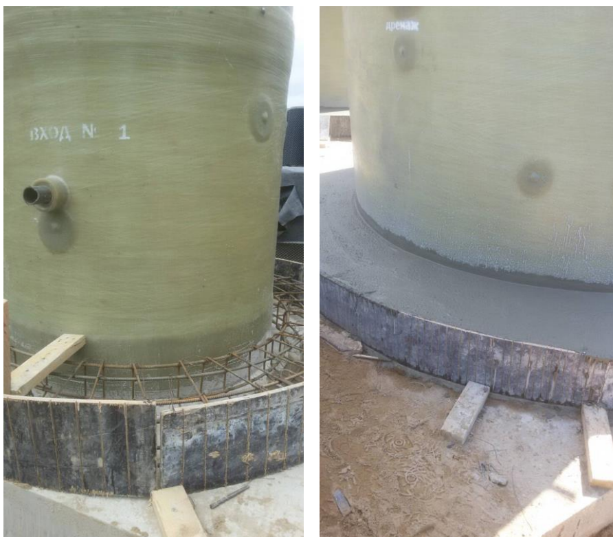
Рисунок 5 – Пример устройства пригруза корпуса
