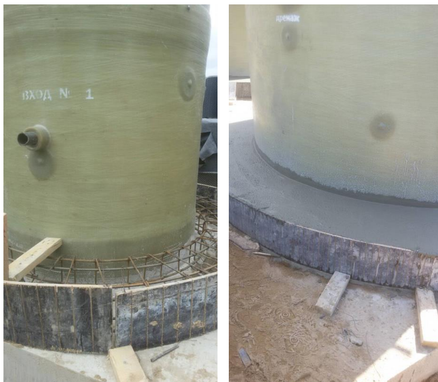
Рисунок 5 – Пример устройства пригруза корпуса
