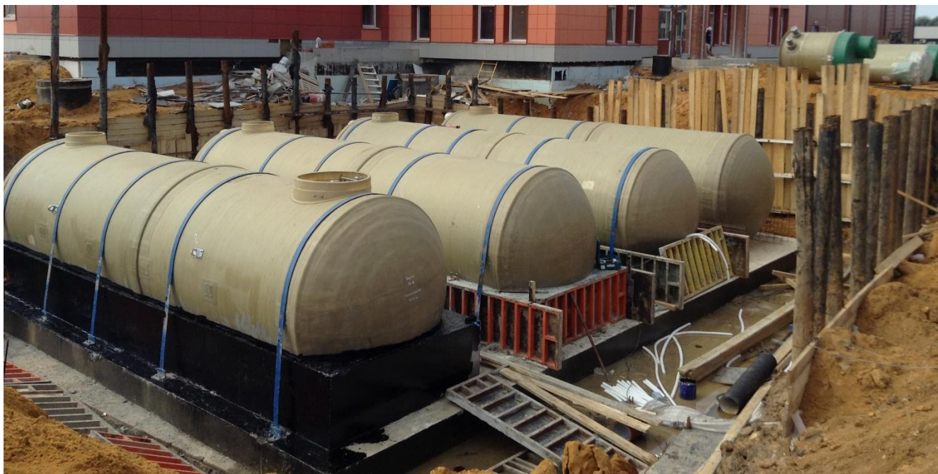
Рисунок 6 – Пример крепления горизонтальных корпусов монтажными лентами
