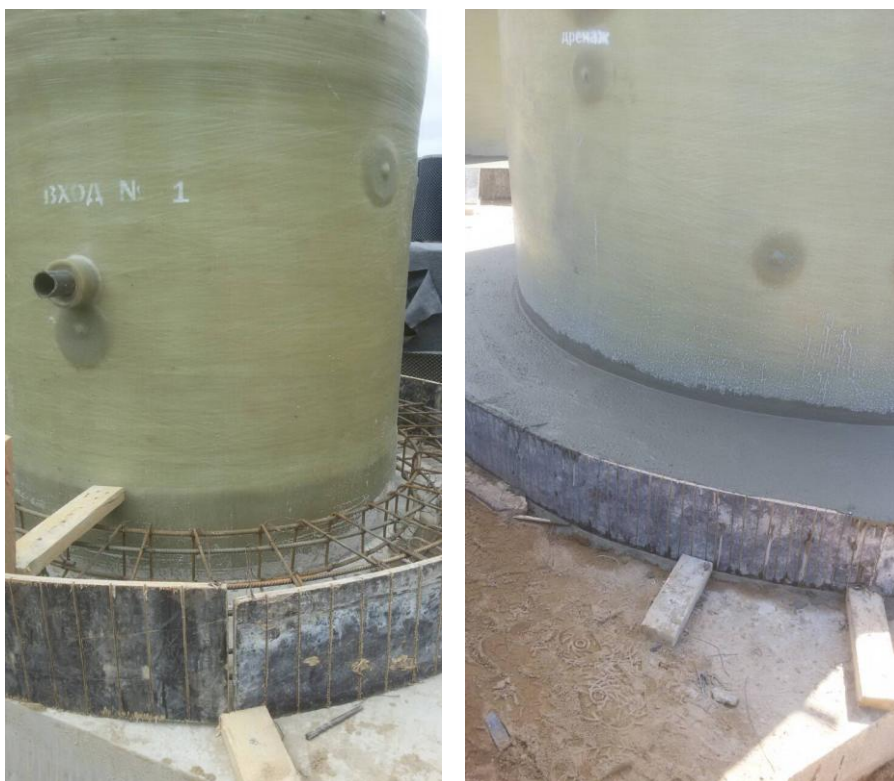
Рисунок 6 – Пример устройства пригруза корпуса
