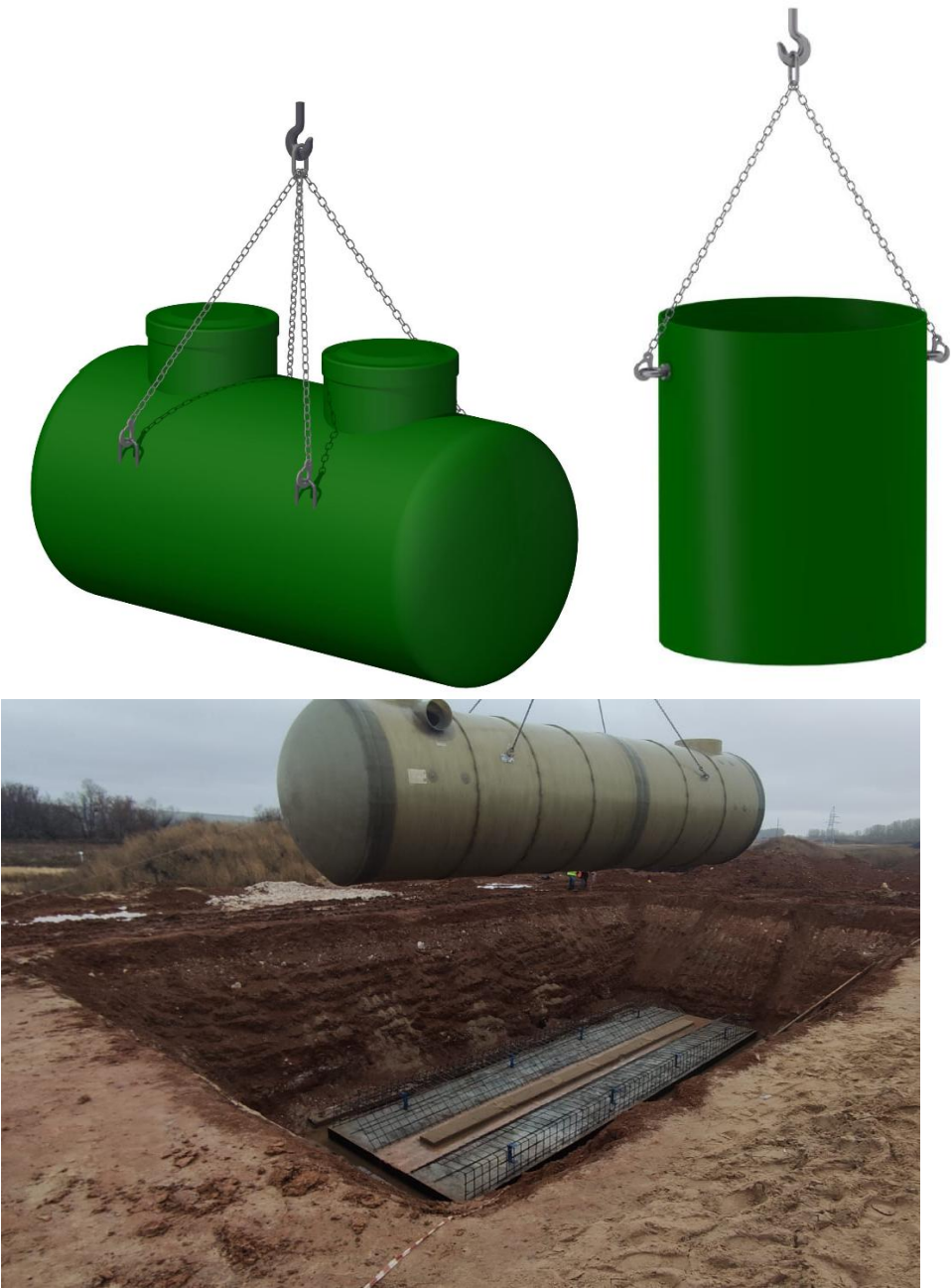
Рисунок 23 – Пример строповки элементов установки
