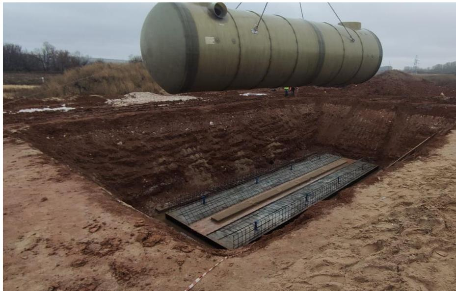
**Рисунок 23** – Пример строповки элементов установки
