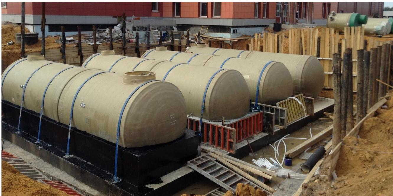
**Рисунок 7** – Пример крепления горизонтальных корпусов монтажными лентами
