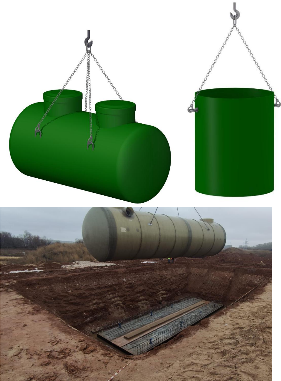
Рисунок 23 – Пример строповки элементов установки
