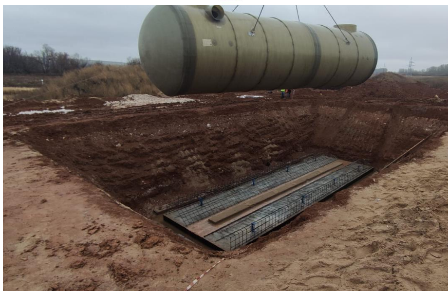
Рисунок 23 – Пример строповки элементов установки
