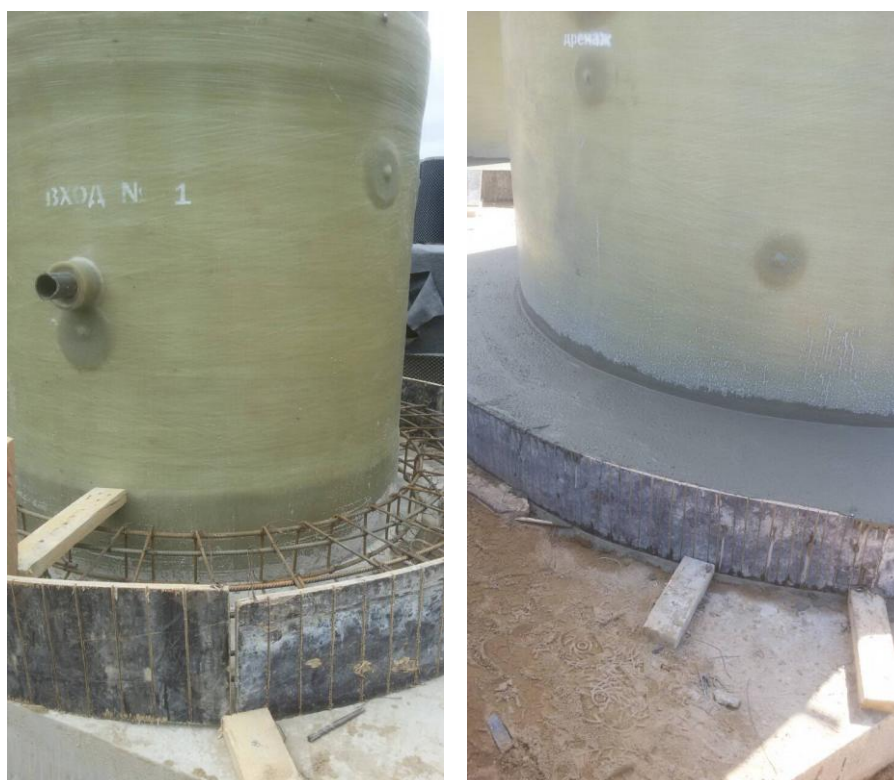
Рисунок 6 – Пример устройства пригруза корпуса
