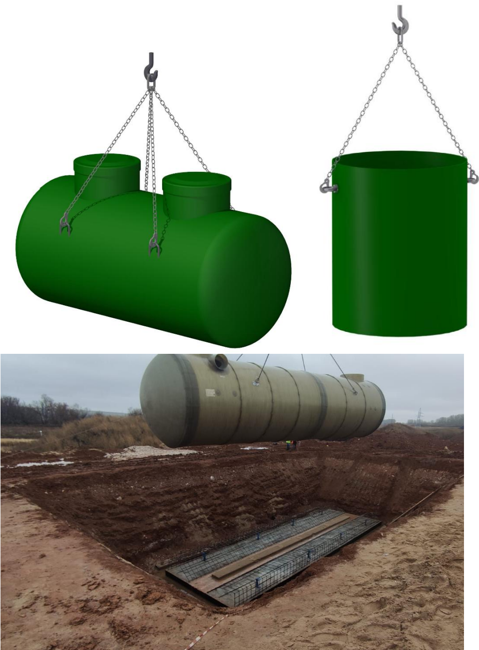
Рисунок 23 – Пример строповки элементов установки
