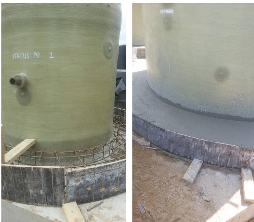
Рисунок 5 – Пример устройства пригруза корпуса
