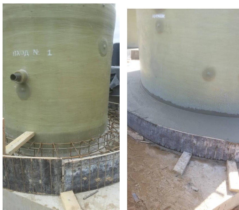
Рисунок 7 – Пример устройства пригруза корпуса
