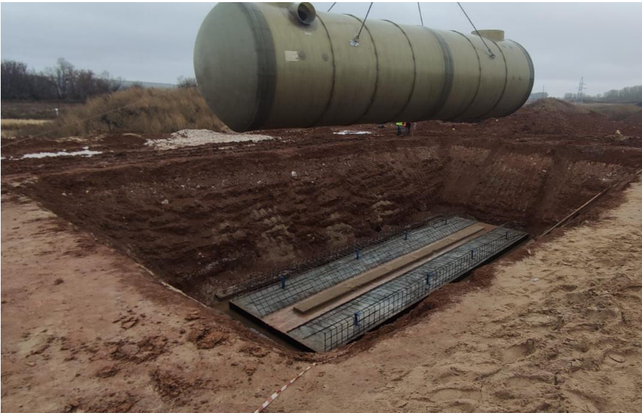
Рисунок 12 – Пример строповки элементов установки
