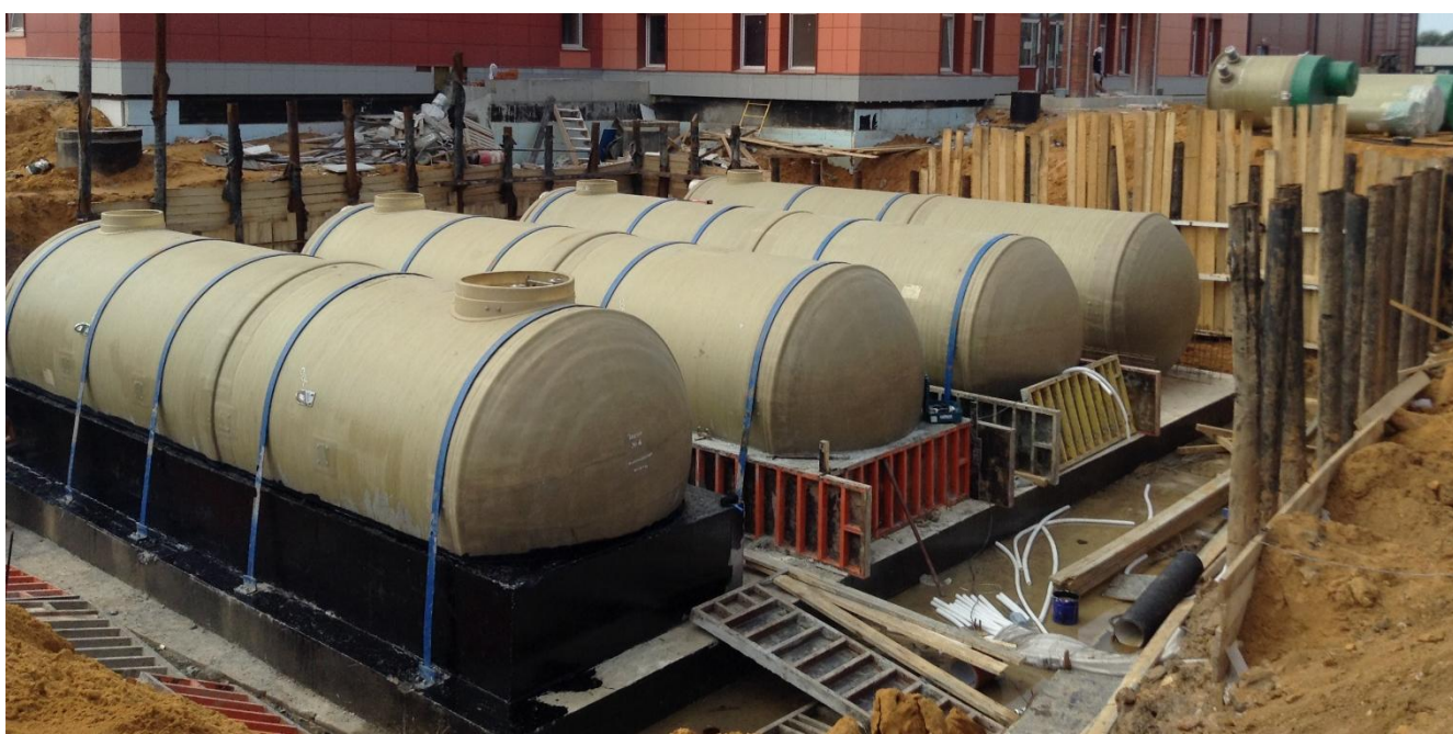
Рисунок 6 – Пример крепления горизонтальных корпусов монтажными лентами
