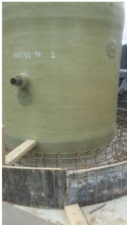
Рис. 8 – Пример устройства пригруза корпуса
