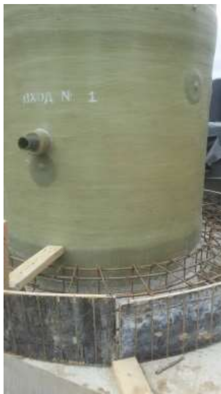
Рис. 11 – Пример устройства пригруза корпуса
