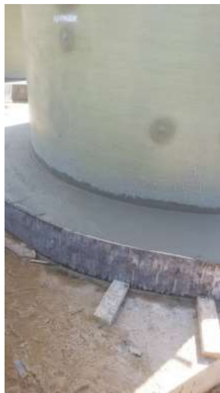
Рис. 11 – Пример устройства пригруза корпуса
