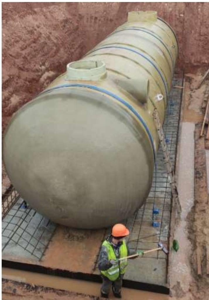
**Рис. 10** – Крепление горизонтального изделия к фундаментной ж/б плите
