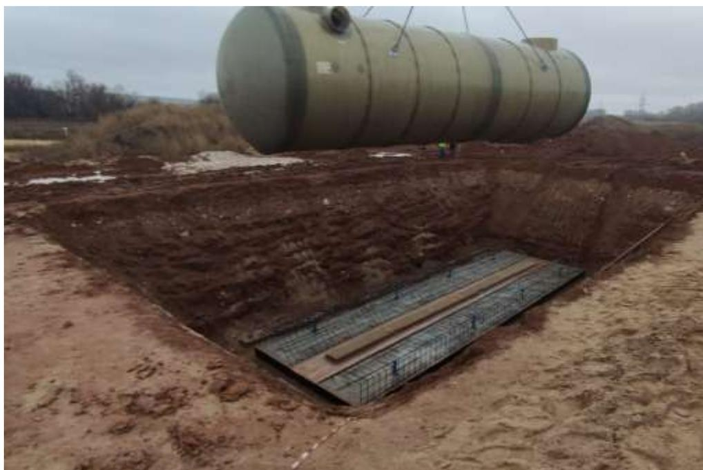
**Рис. 10** – Метод строповки стеклопластиковых корпусов изделий
