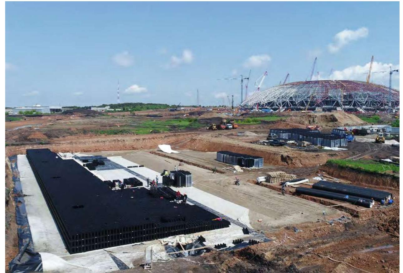
Комплекс очистных сооружений с каскадом бетонных аккумулирующих резервуаров ACO StormBrixx при строительстве объекта Стадион «Самара Арена»
