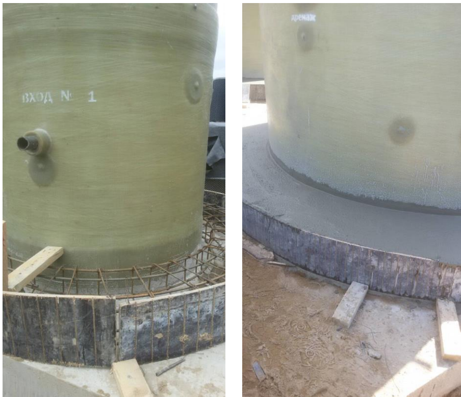
Рис. 8 – Пример устройства пригруза корпуса
