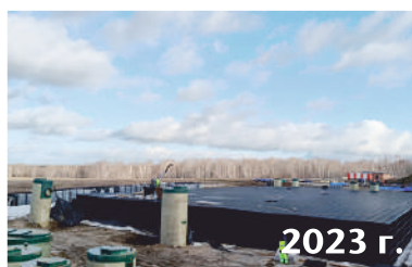
2023 г. Рекультивация полигона ТБО, г. Белгород. Резервуары в составе ЛОС
