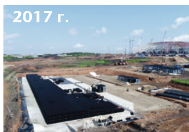
2017 г. Стадион «Самара Арена». Резервуары в составе ЛОС и в качестве буфера ЛНС
