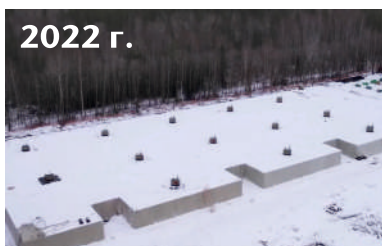
2022 г. Полигон пром. отходов «Красный Бор» Ленинградская обл. Резервуар в составе ЛОС, противифльтрационная завеса
