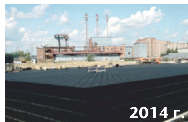
2014 г. Транспортная развязка МКАД - М-1 «Беларусь», Московская обл. Резервуар в составе ЛОС
