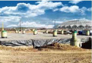
Стадион "Самара Арена" Комплекс КНС и ЛОС с резервуарами ACO StormBrixx
