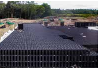
Автомобильный кластер, Калининград, ЛОС с резервуарами ACO StormBrixx
