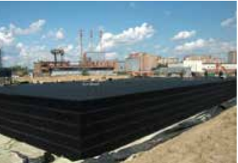
Транспортная развязка МКАД - М1 "Беларусь", Московская обл. ЛОС с резервуаром ACO StormBrixx
