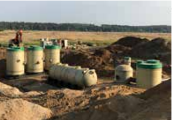
Центральная кольцевая автодорога Комплекс ЛОС и КНС для 5го пускового комплекса, Московская обл.
