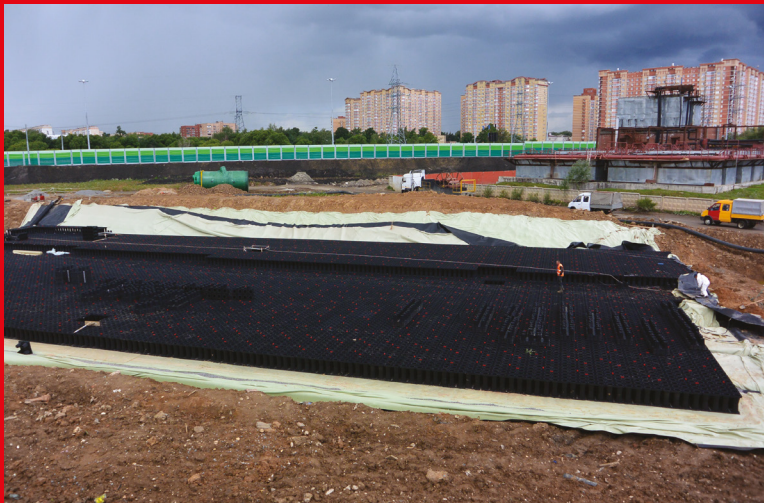
■ Аккумулирующая емкость объемом 5000 м 3 в составе очистных сооружений дождевой канализации транспортной развязки МКАД и магистрали М1 "Беларусь", Московская обл.
