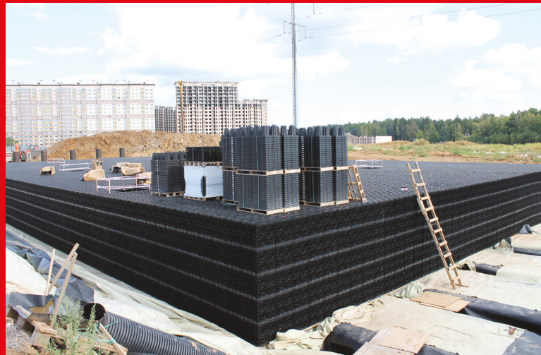
■ Аккумулирующая емкость объемом 5000 м 3 в составе очистных сооружений дождевой канализации транспортной развязки МКАД и магистрали М1 "Беларусь", Московская обл.
