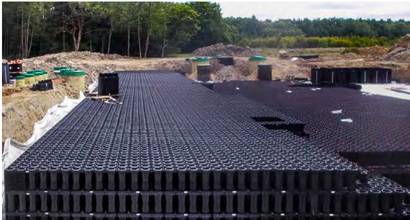
Инженерная инфраструктура г. Усть-Каменогорск Очистные сооружения поверхностного стока, аккумулирующий резервуар из блоков для безбетонного аккумулирования сточных вод ACO StormBrixx на территории Южного планировочного района г. Усть-Каменогорск, Республика Казахстан.
