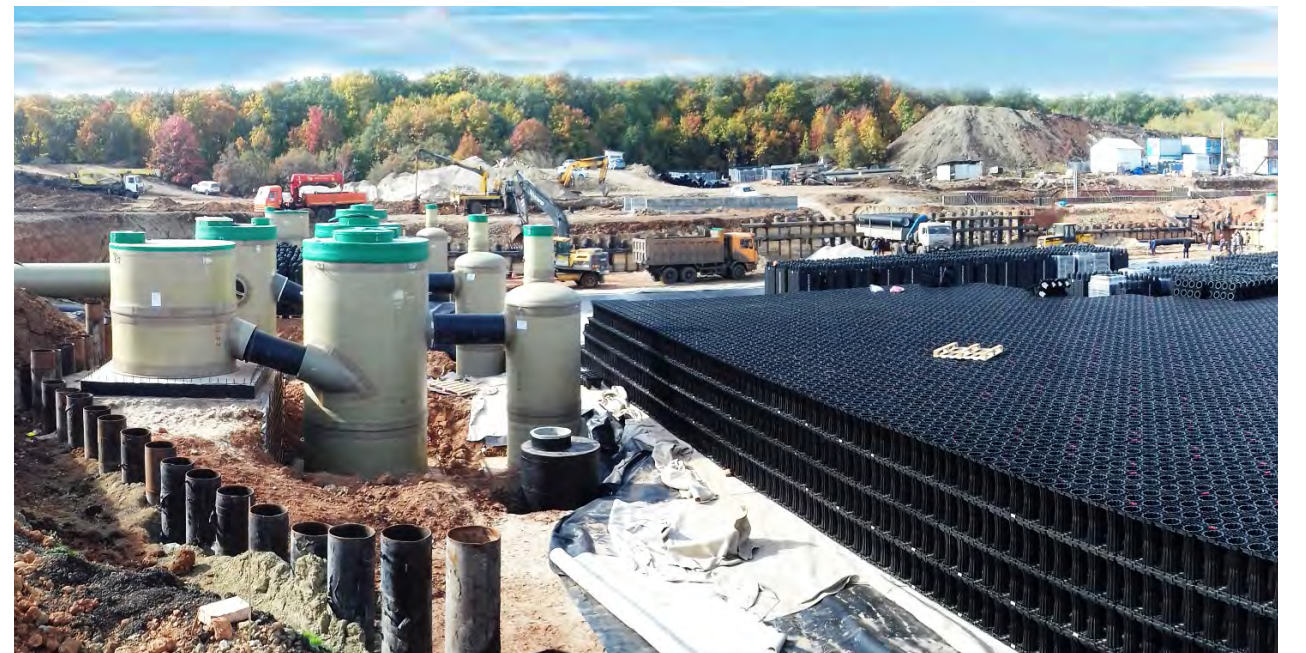
Совместное использование сепаратора ЦКЛ с резервуарами ACO StormBrixx
