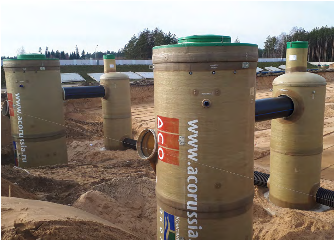
Индустриальный парк "Великий камень" Оборудование для очистки поверхностного стока в составе ЛОС накопительного типа с самым большим в мире безбетонным аккумулярующим резервуаром ACO StormBrixx, Минск, Республика Беларусь
