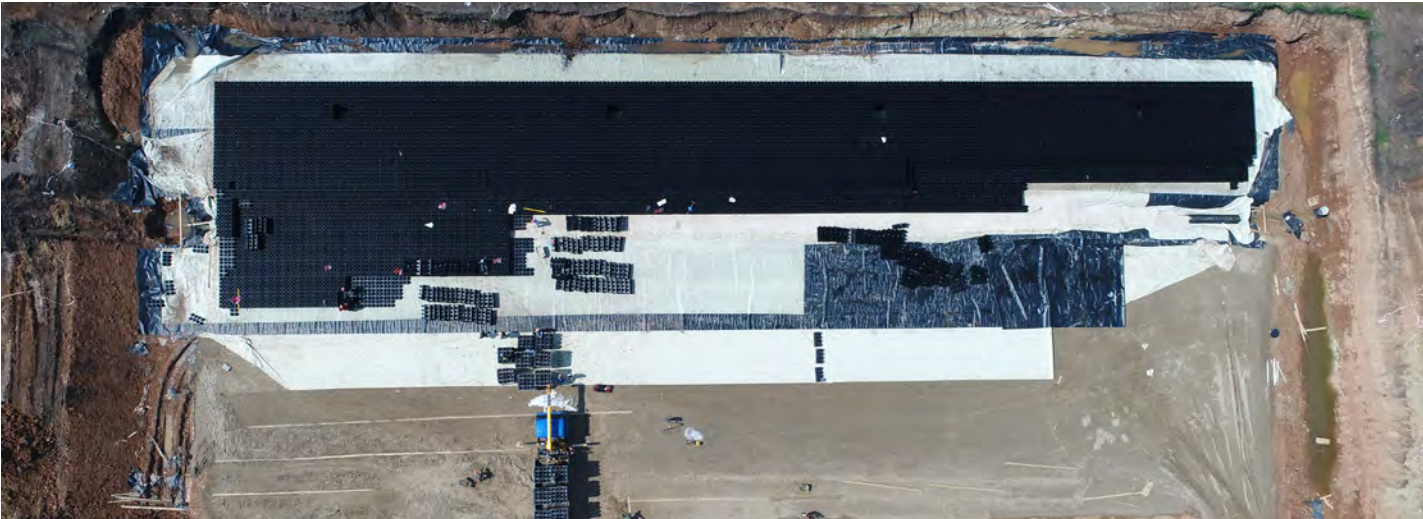
Стадион "Самара Арена" Каскадная система безбетонных аккумулирующих резервуаров ACO StormBrixx с комплексом сооружений для очистки и перекачки поверхностного стока, г. Самара.
