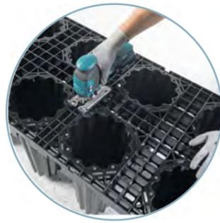
В зависимости от конфигурации системы модульные элементы при необходимости можно разрезать пополам.
