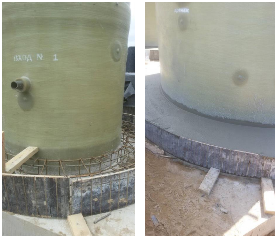
Рис. 8 – Пример устройства пригруза корпуса
