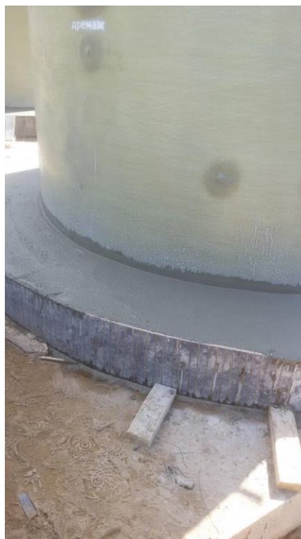
Рисунок 3 – Пример устройства пригруза корпуса
