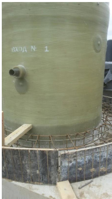
Рисунок 3 – Пример устройства пригруза корпуса
