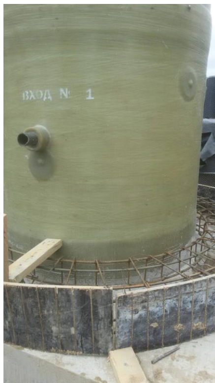
Рис. 8 – Пример устройства пригруза корпуса
