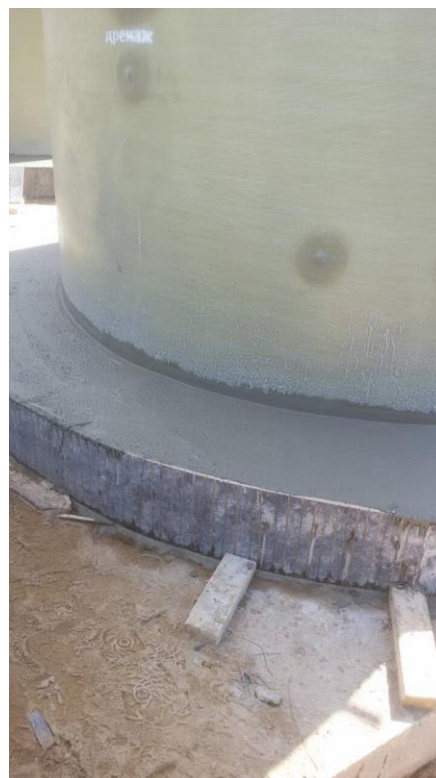
Рис. 8 – Пример устройства пригруза корпуса
