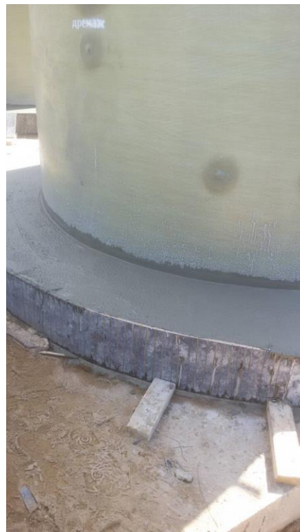
Рисунок 6 – Пример устройства пригруза корпуса
