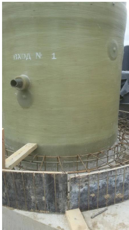
Рисунок 6 – Пример устройства пригруза корпуса
