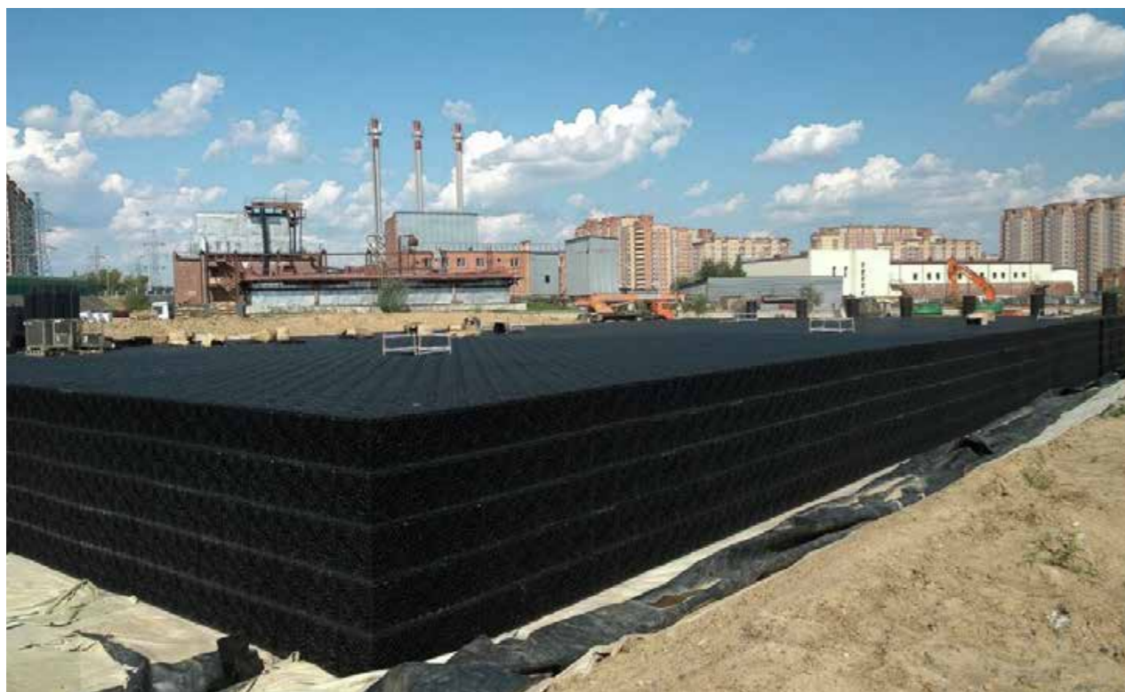
Транспортная развязка МКАД - М1 "Беларусь" Очистные сооружения поверхностного стока накопительного типа с безбетонным аккумулярующим резервуаром ACO StormBrixx, Одинцово, Московская обл.
