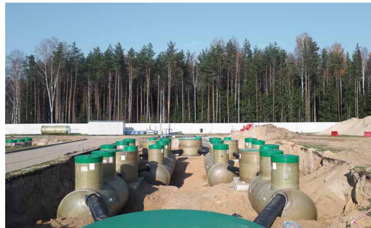
Индустриальный парк "Великий камень" Оборудование для очистки поверхностного стока в составе ЛОС накопительного типа с самым большим в мире безбетонным аккумулярующим резервуаром ACO StormBrixx, Минск, Республика Беларусь
