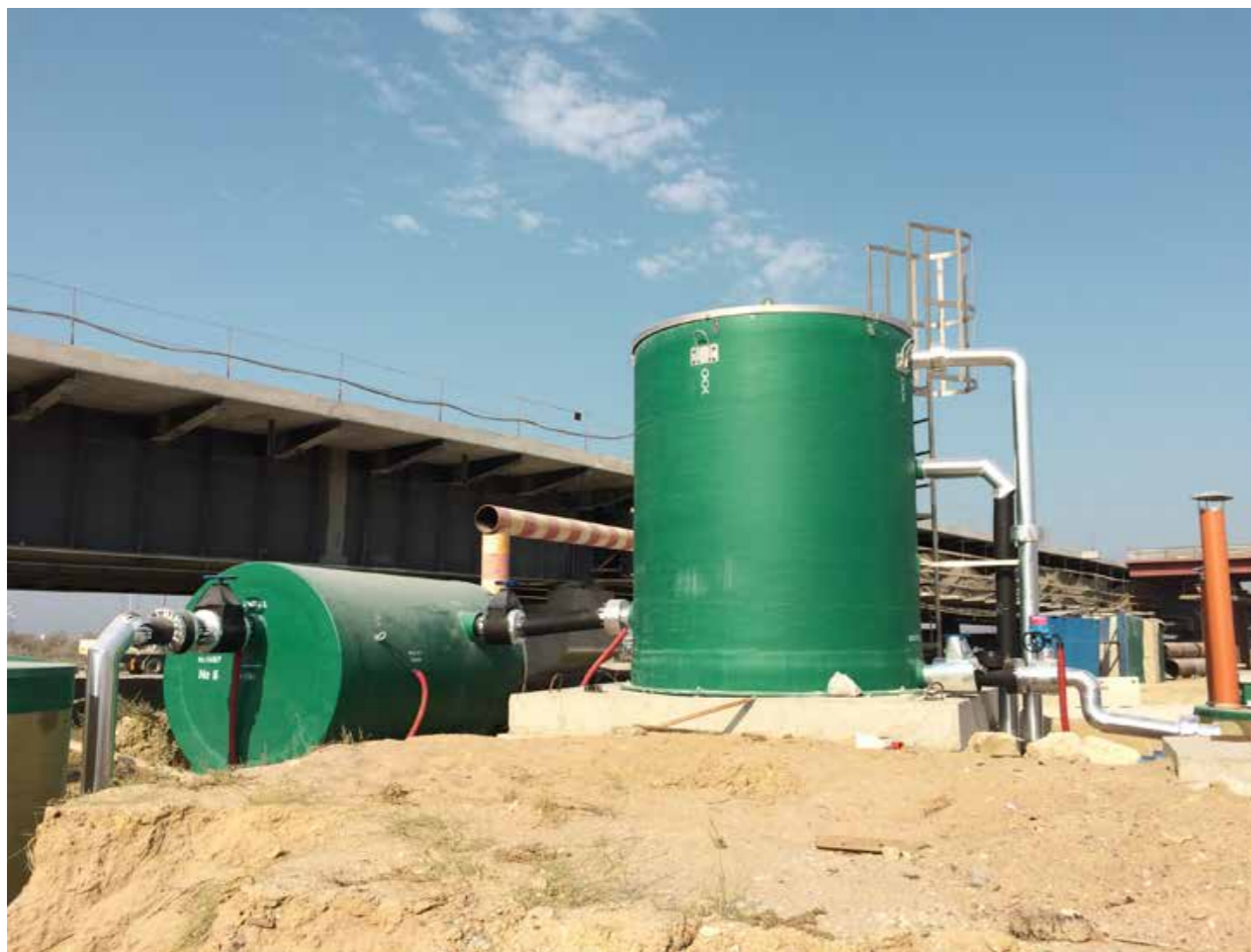
Керченский мост Очистные сооружения поверхностного стока в наземном исполнении
