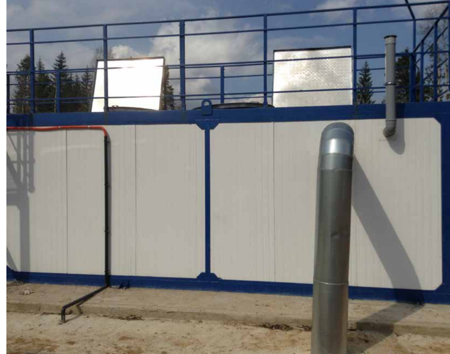
Очистное оборудование в наземном исполнении на объекте «Военно-патриотический парк культуры и отдыха ВС РФ «ПАТРИОТ», Московская область, г. Кубинка
