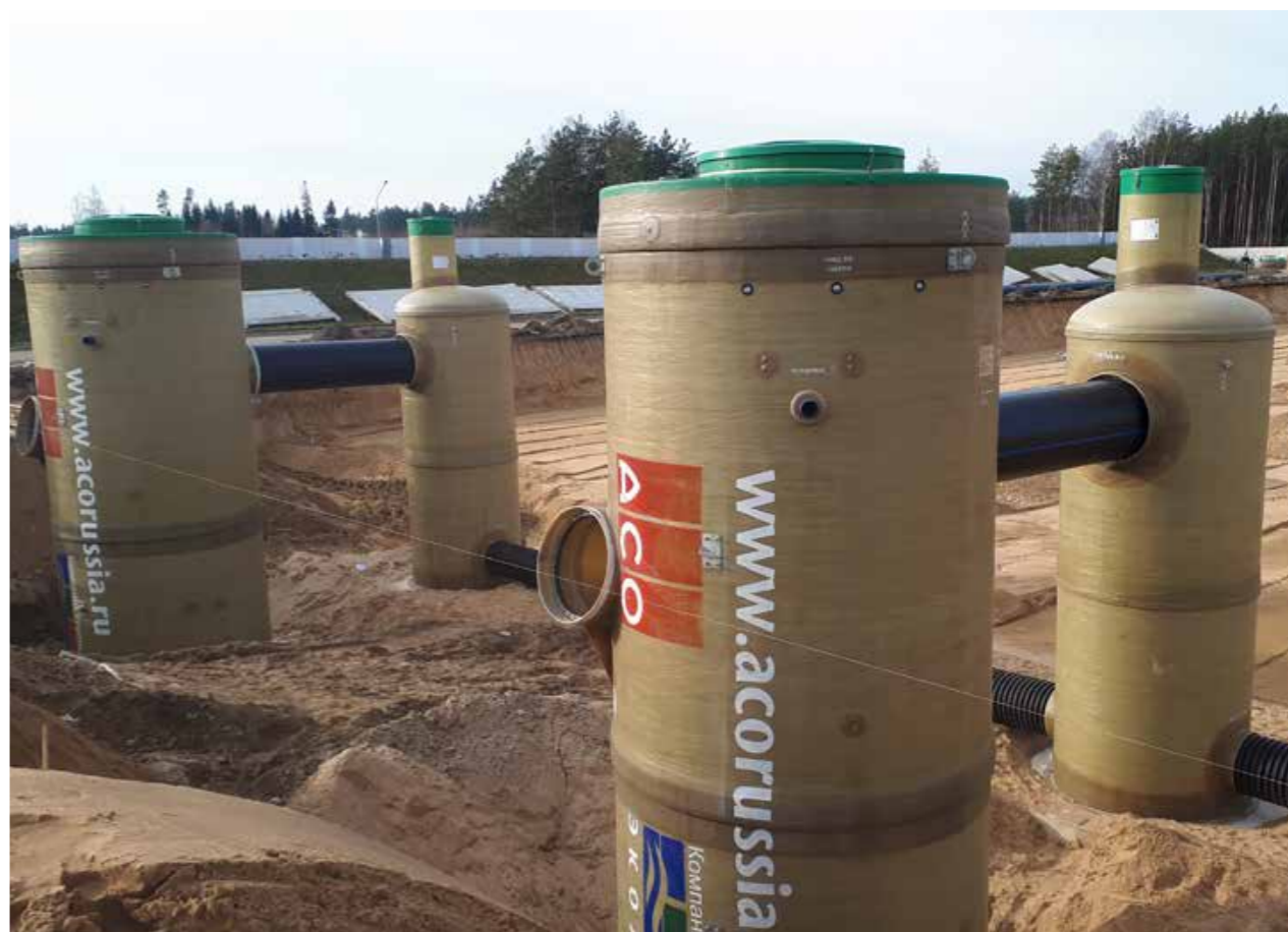
Индустриальный парк "Великий камень" Оборудование для очистки поверхностного стока в составе ЛОС накопительного типа с самым большим в мире безбетонным аккумулярующим резервуаром ACO StormBrixx, Минск, Республика Беларусь
