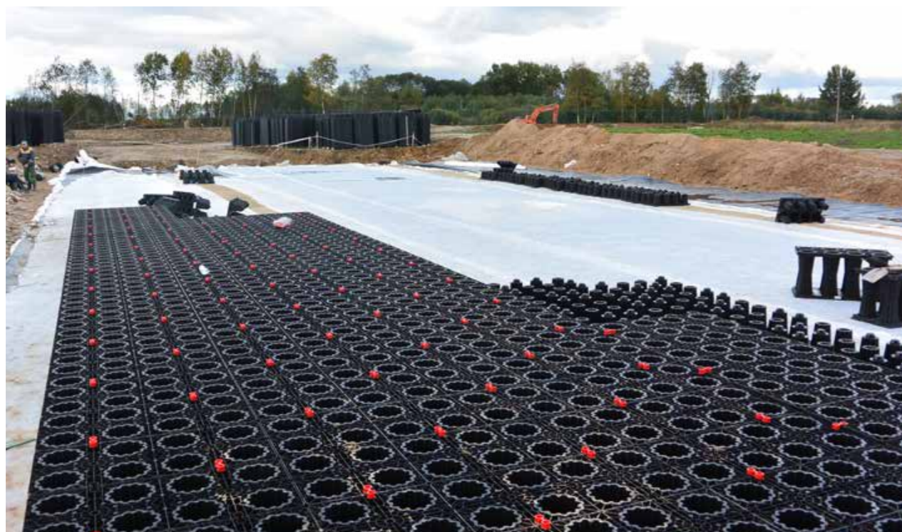
Особая экономическая зона "Моглино" Очистные сооружения поверхностного стока накопительного типа с безбетонным резервуаром ACO StormBrixx, Псковская обл.
