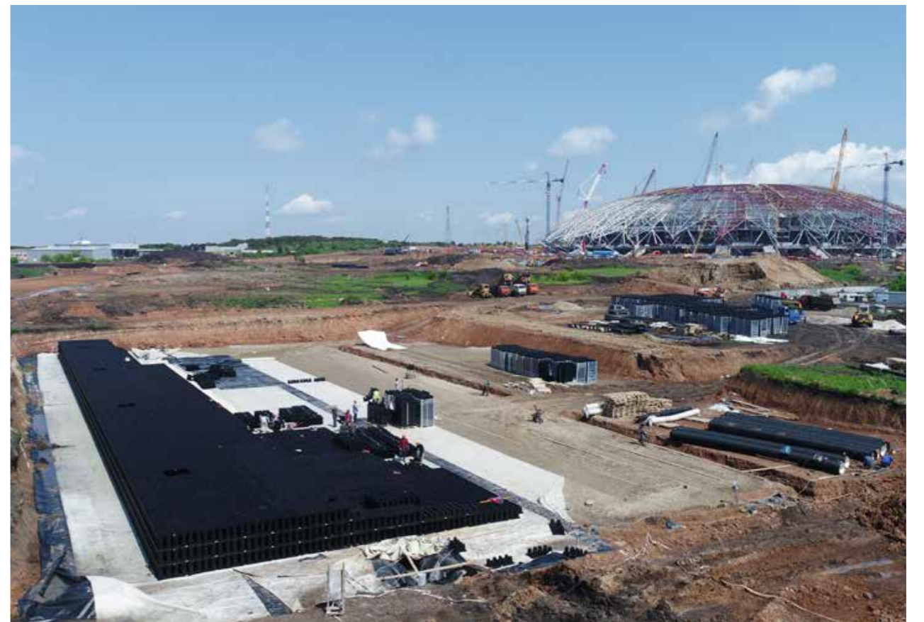
Комплекс очистных сооружений с каскадом безбетонных аккумулирующих резервуаров ACO StormBrixx при строительстве объекта Стадион «Самара Арена»
