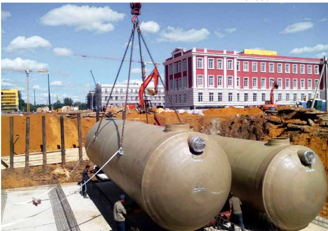
Тульское суворовское военное училище Очистные сооружения поверхностного стока накопительного типа с резервуарами из стеклопластика
